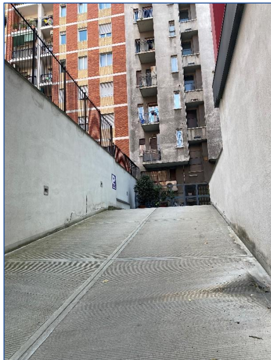
Foto 2 - rampa comune per il Piano S1
