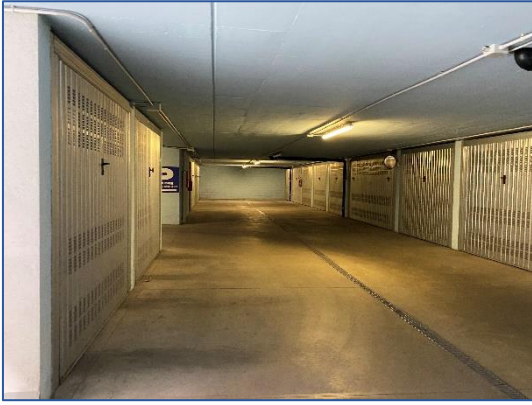
Foto 5 - spazi di manovra comune - Piano S1
