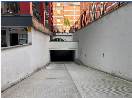
Foto 1 - rampa comune per il Piano S1
