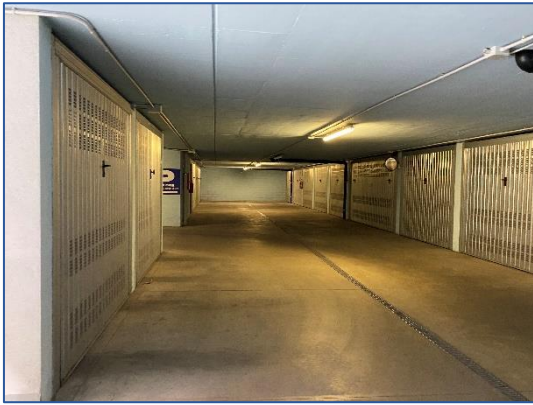
Foto 5 - spazi di manovra comune - Piano S1
