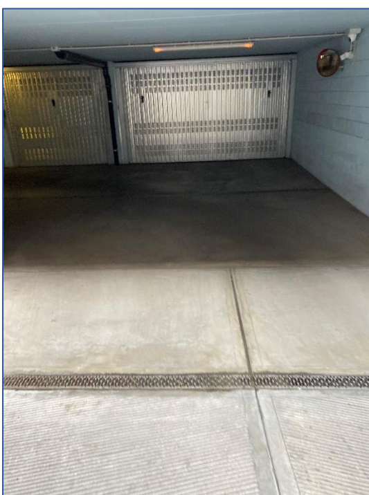
Foto 3 - spazi di manovra comune - Piano S1
