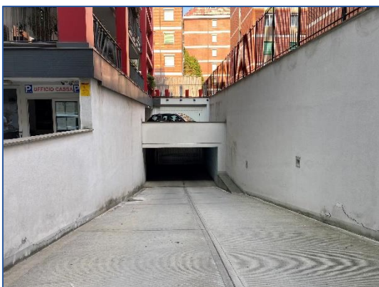
Foto 1 - rampa comune per il Piano S1
