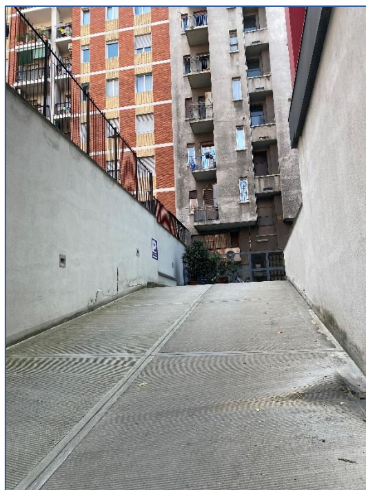
Foto 2 - rampa comune per il Piano S1
