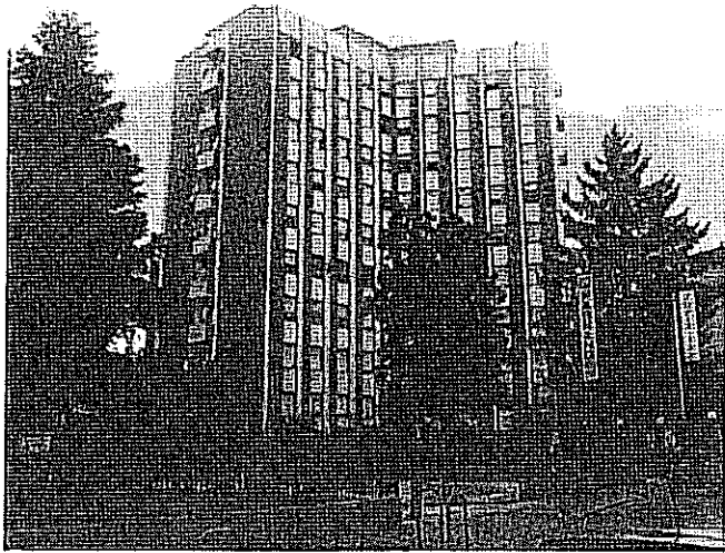
Vista 1 - Prospetto Principale
