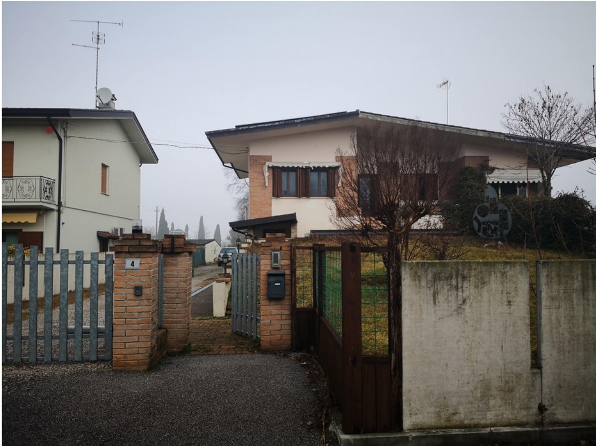
1 - fronte sud accesso pedonale
