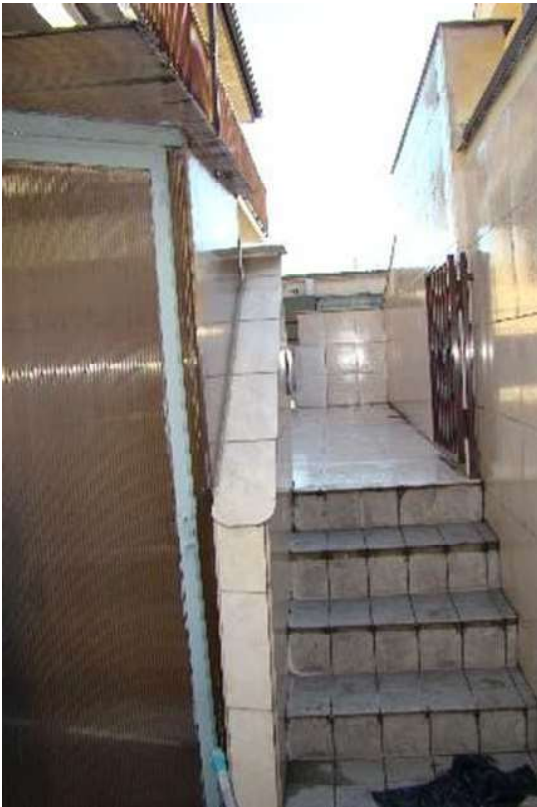
18. Vista della scala di accesso dal terrazzo alla "zona giardino".
