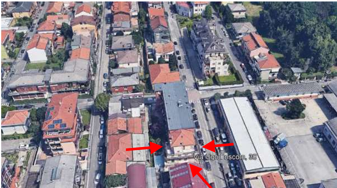
3. Rilievo fotografico del contesto. Vista aerea dell'edificio con indicazione degli affacci degli immobili.
