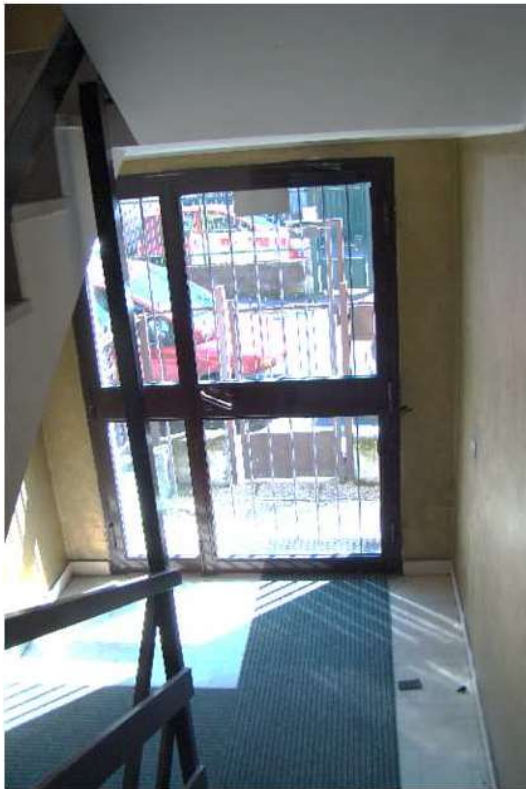
4. Dettaglio del portone di accesso alla scala.
