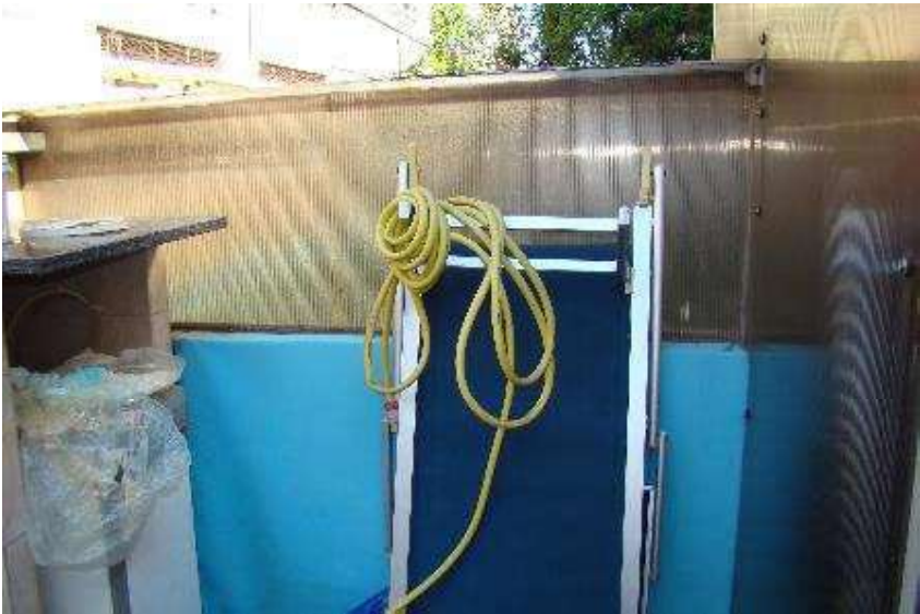
20. Vista della copertura della piscina.
