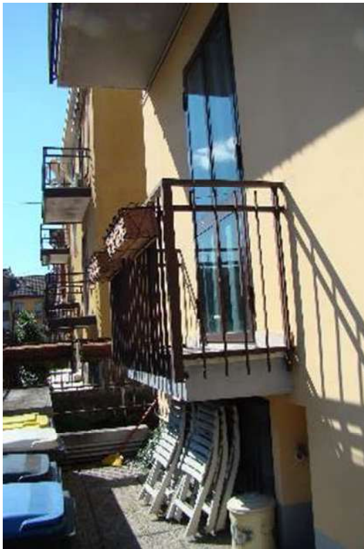
24. Vista del balcone su strada.
