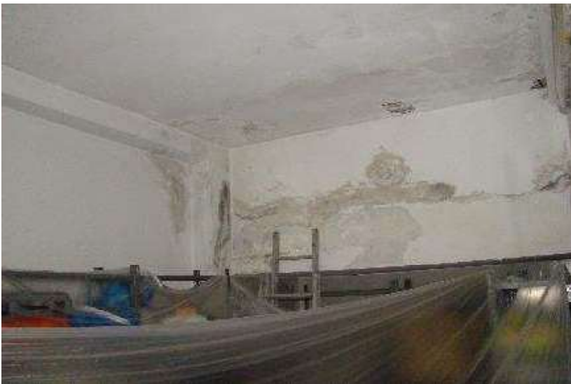
30. Dettaglio del plafone dell'autorimessa.
