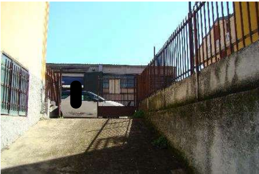
28. Vista della rampa di accesso all'autorimessa.
