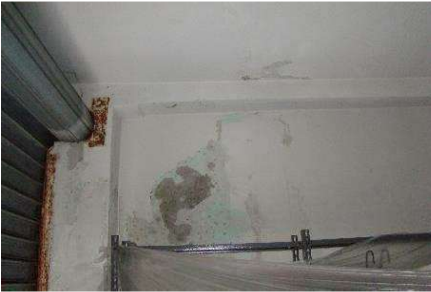
31. Dettaglio del plafone dell'autorimessa.
