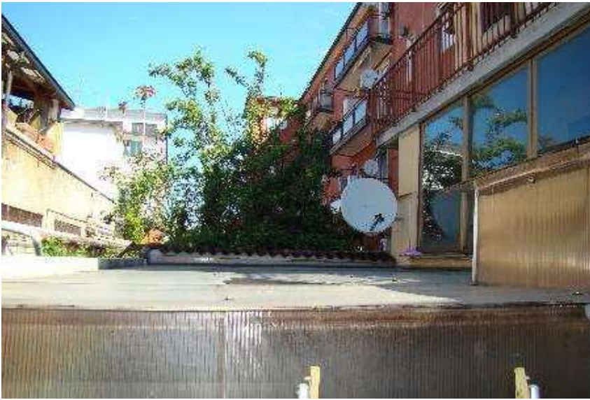
19. Vista della copertura della piscina.
