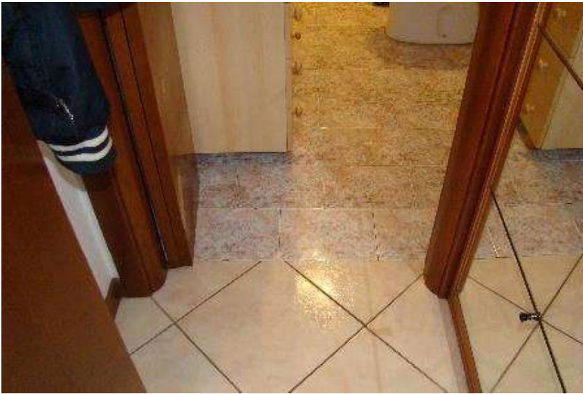
13. Dettaglio della pavimentazione.
