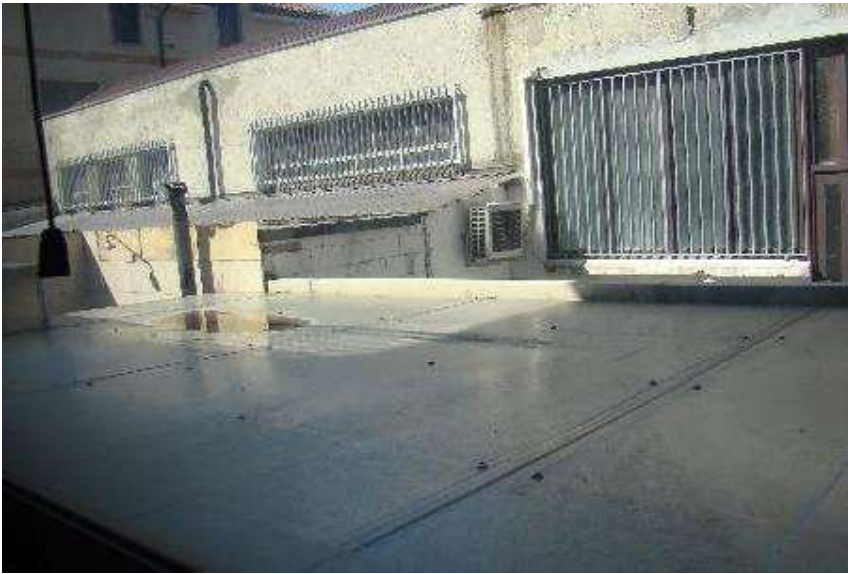
23. Vista della copertura della piscina dalla veranda.
