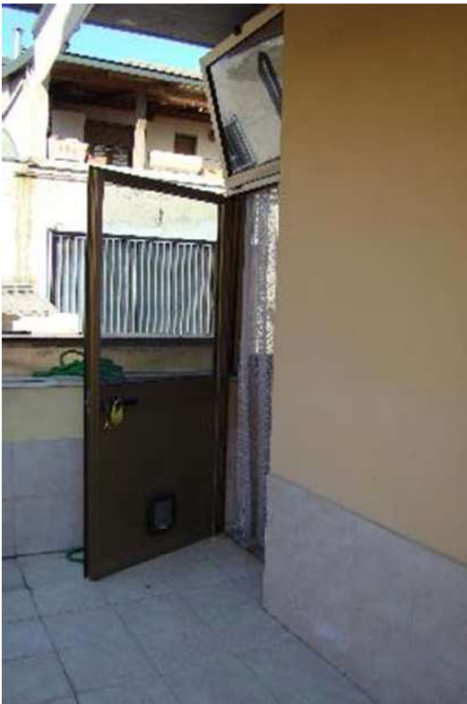
16. Vista dell'accesso dalla veranda al terrazzo.
