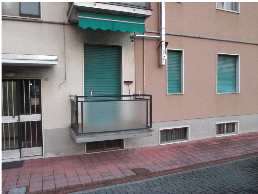
Foto 3: civico 84 e appartamento P.R. balcone cucina, bagno e camera
