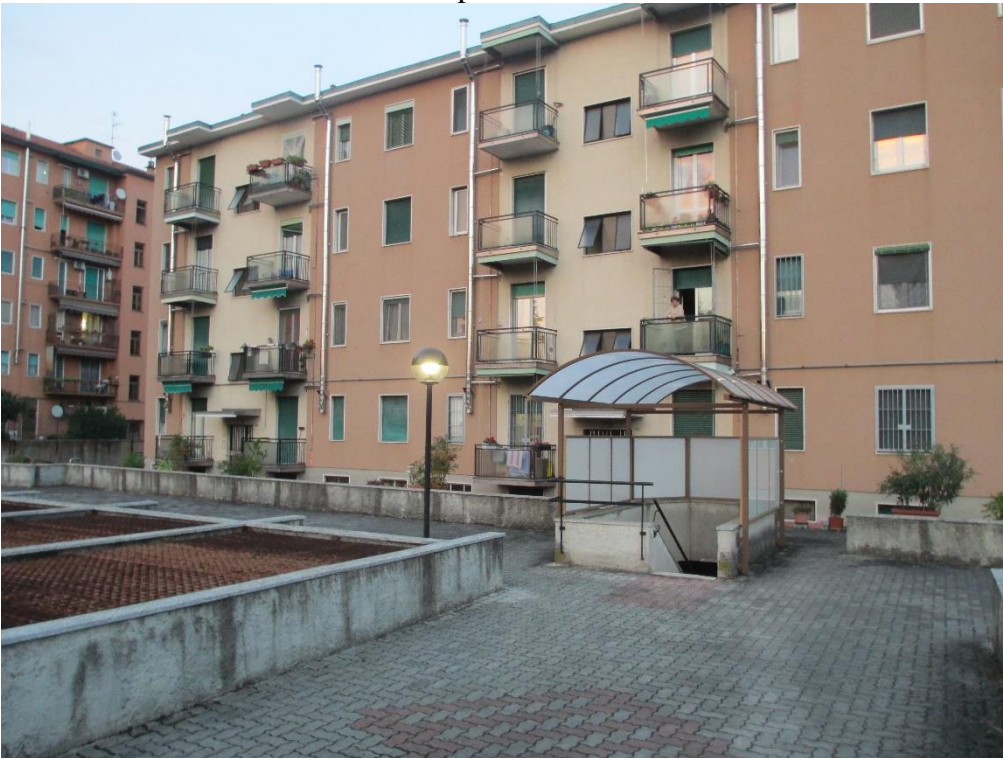
Foto 2: come sopra visto dall'interno dalla recinzione
