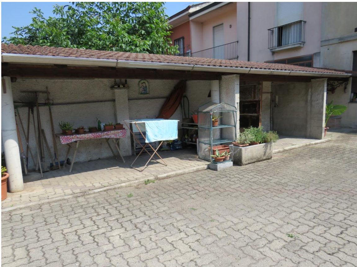
COPERTURA DA REGOLARIZZARE
