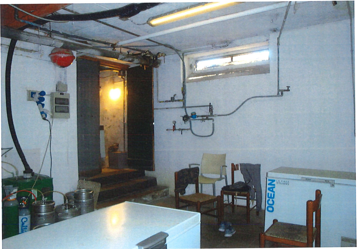
R.G.E. 188/2021 G. E. Dott.ssa M.G. Mennuni Gorgonzola, Via Per Cascina Antonietta 31, Foglio 12, mapp. 56, sub. 1 Prospetti interni: la cantina al piano interrato
