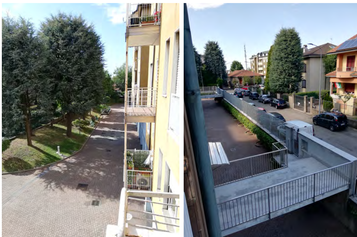
Fig. 6 - 7: accesso dalla via San Giovanni Bosco e contesto, giardino condominiale
