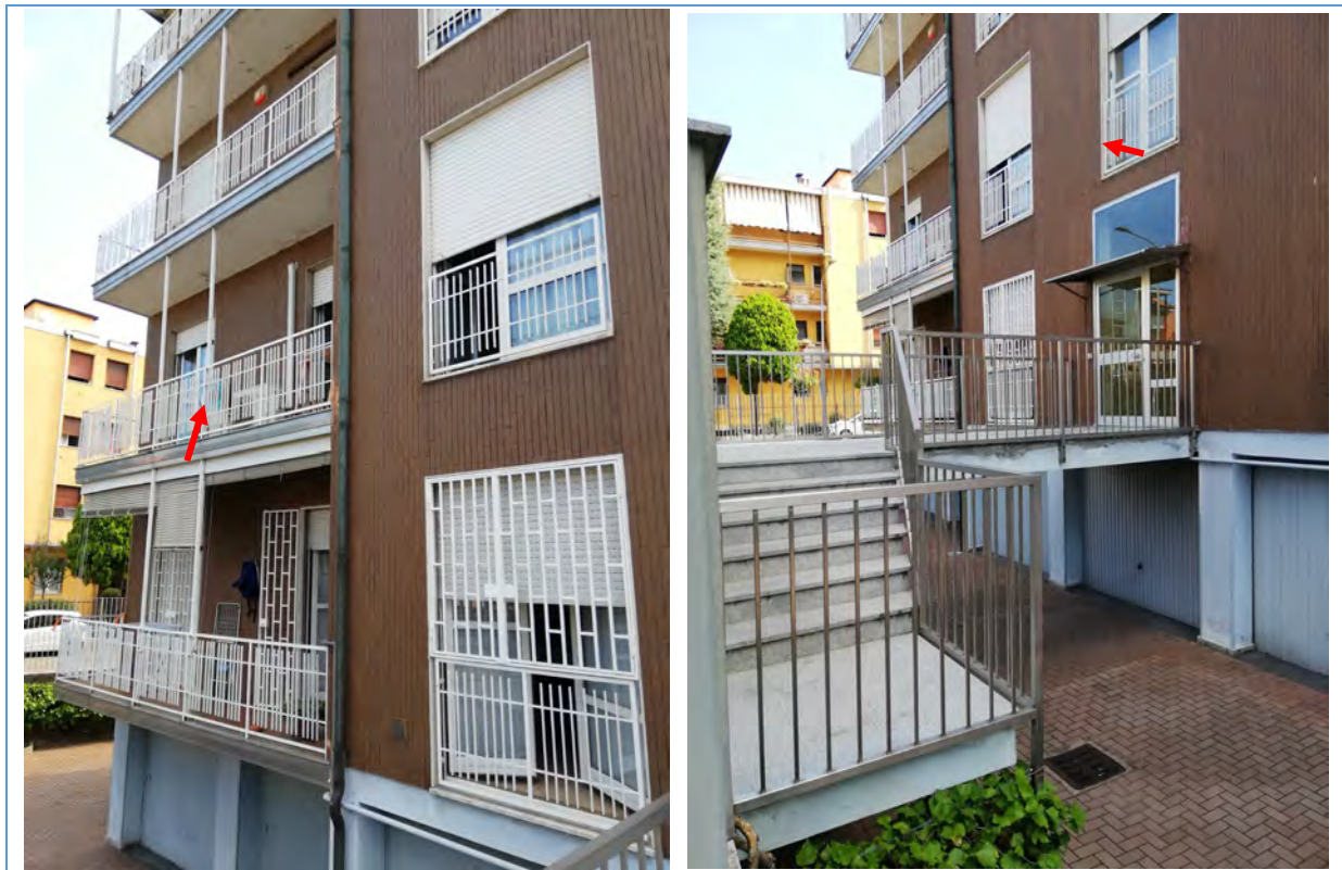
Fig. 2 - 3: vista fabbricato e accesso dalla strada, individuazione immobile
