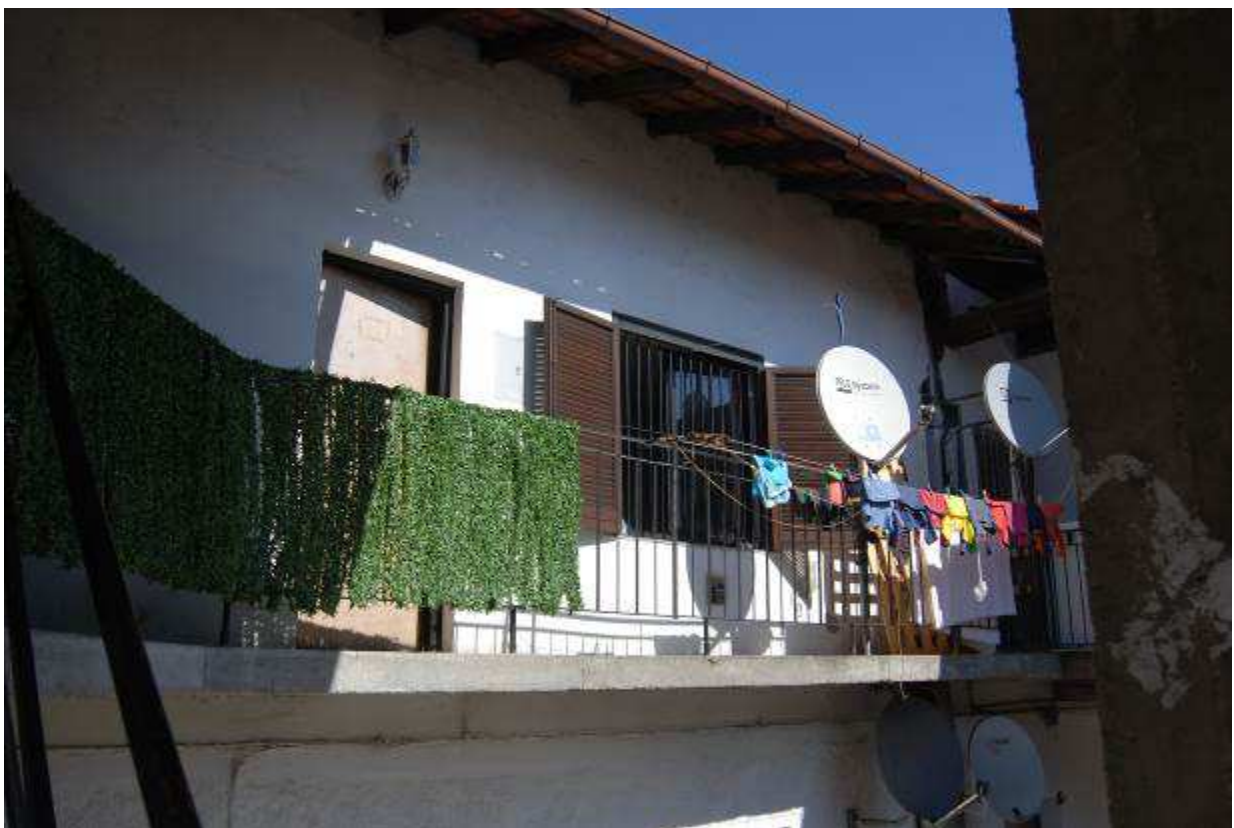
Foto 2: ballatoio comune d'accesso all'immobile
