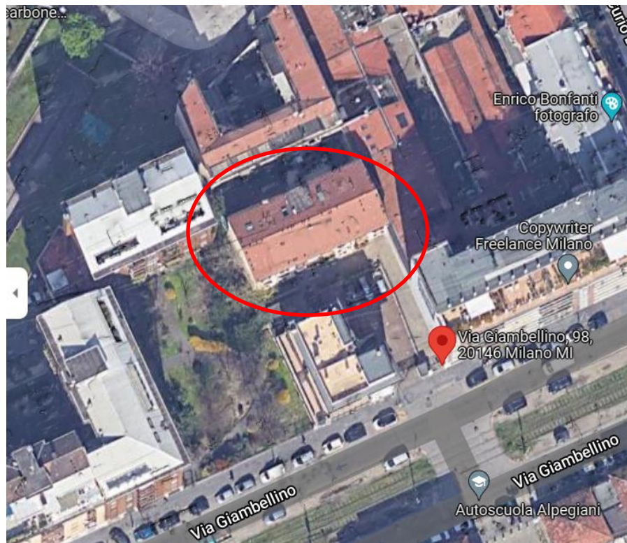
VIA GIAMBELLINO 98 - EDIFICIO A
