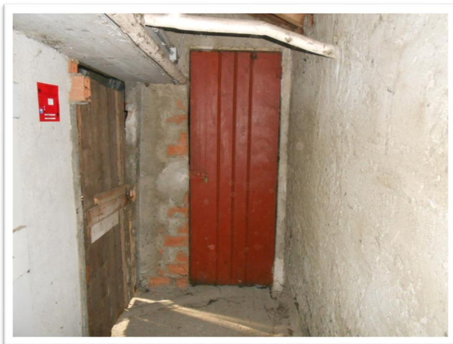
Foto 20 porta ingresso al solaio
