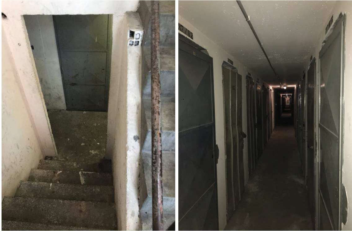
Immagini 27. 28. La scala di accesso alla cantina e il corridoio che distribuisce i diversi vani.
