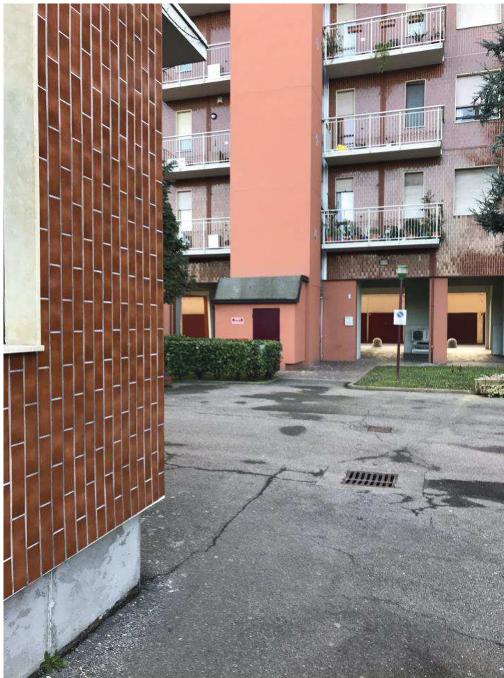
Immagine 6. Il cortile interno del fabbricato.
