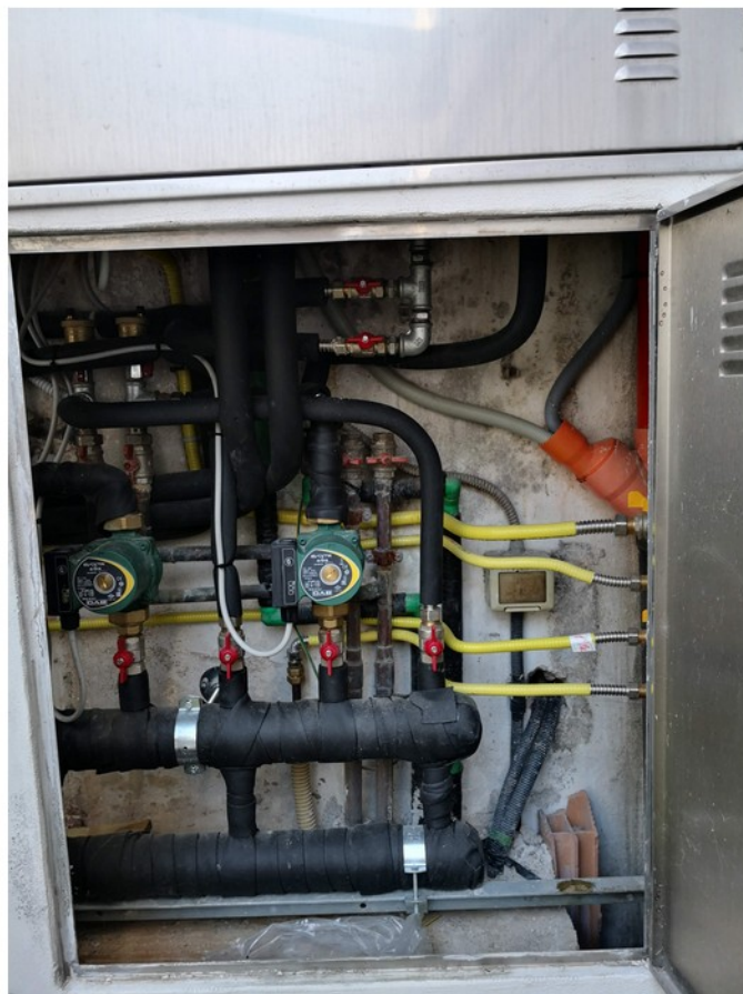
69 - impianto idro termo sanitario distribuzione
