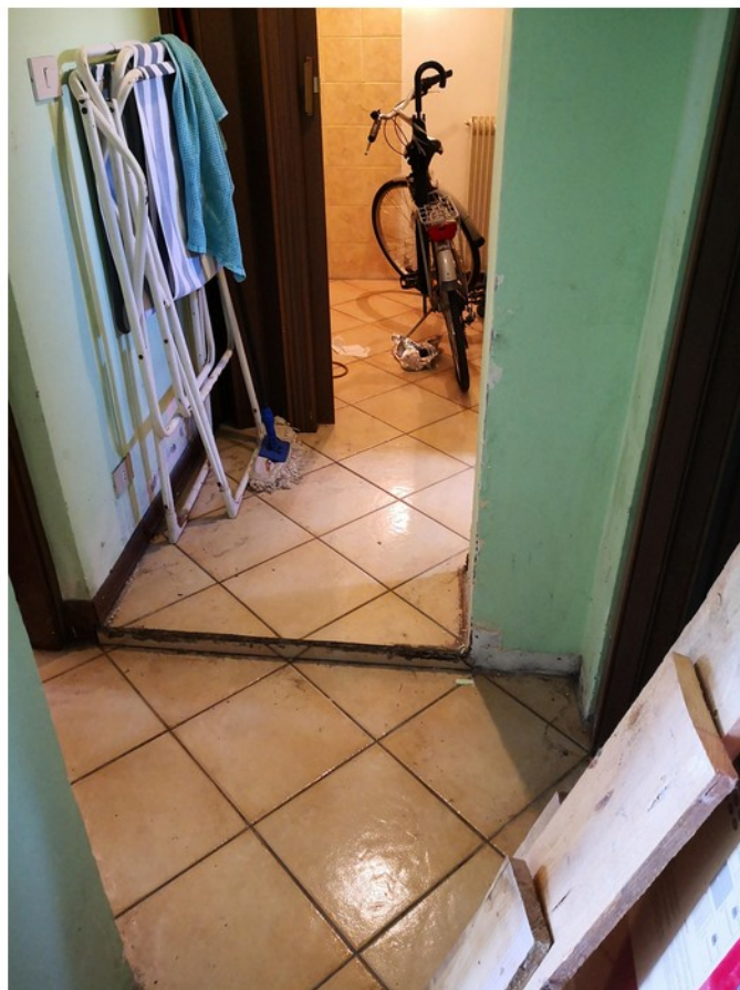
21 - corridoio piano terra
