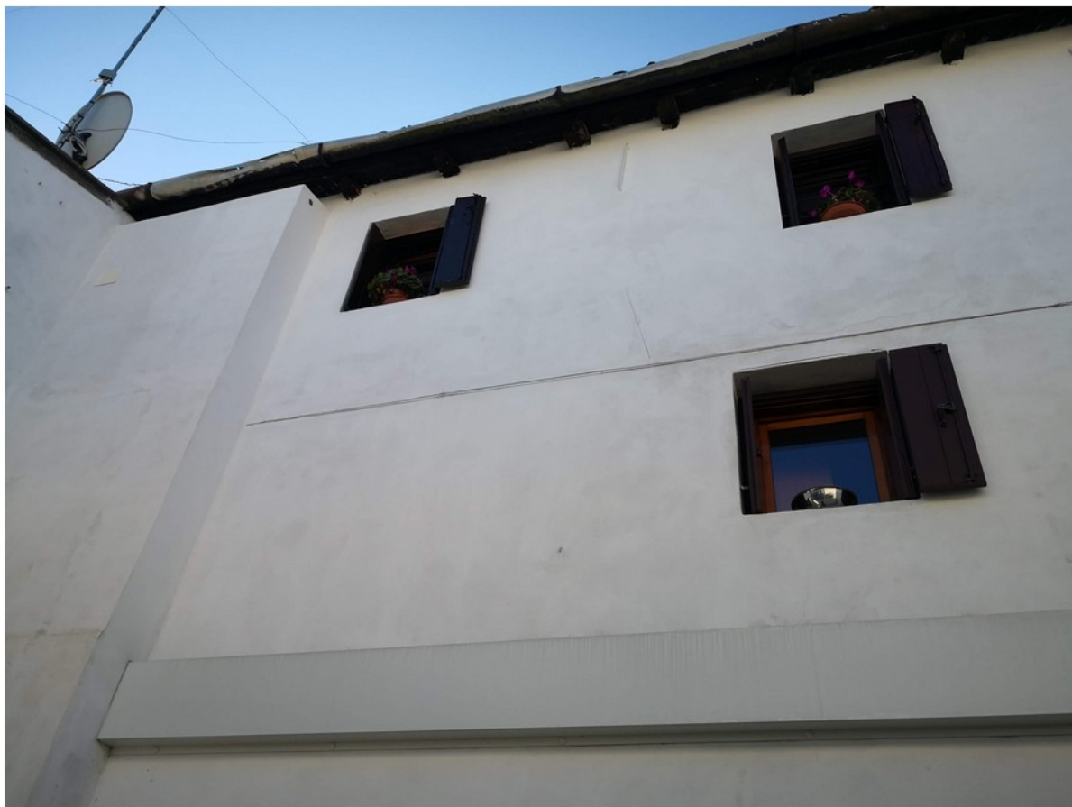
71 - facciata interna nord
