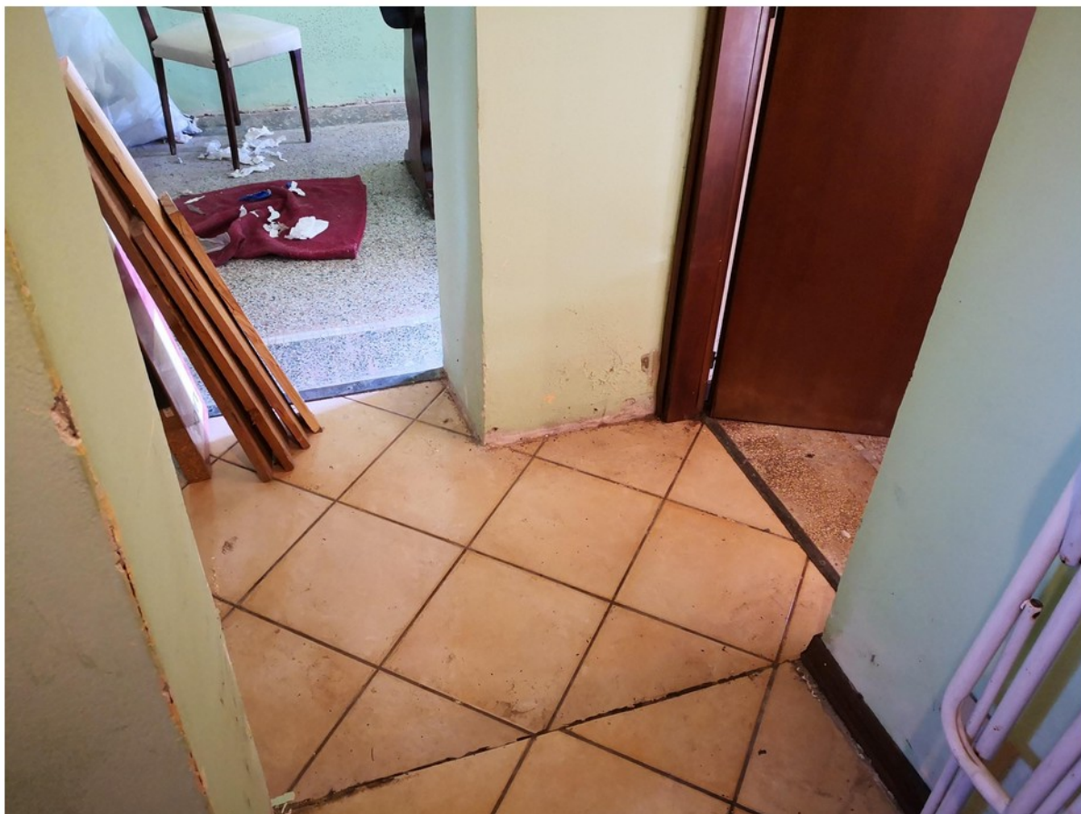
13 - corridoio piano terra
