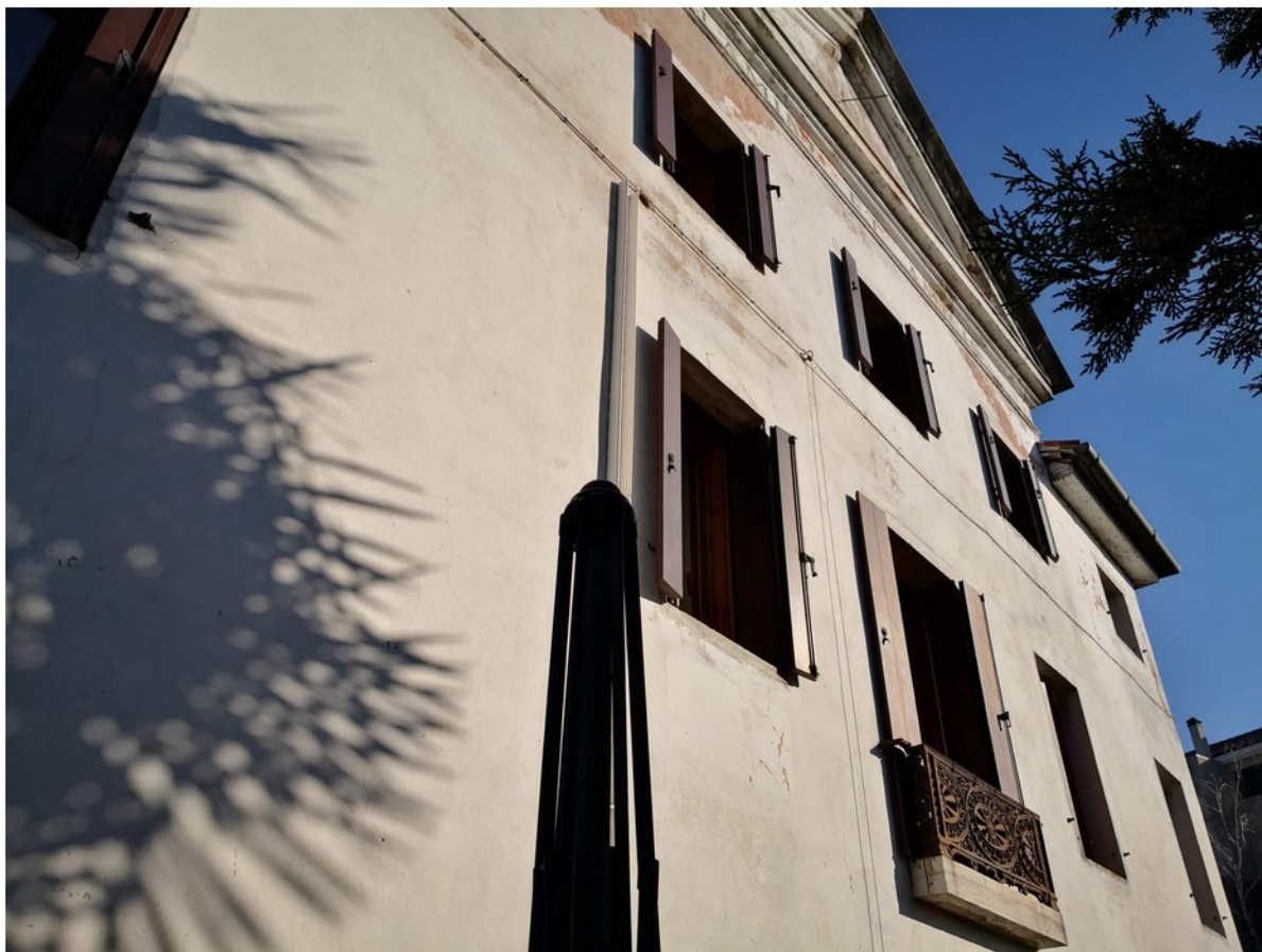
61 - facciata frontsle sud
