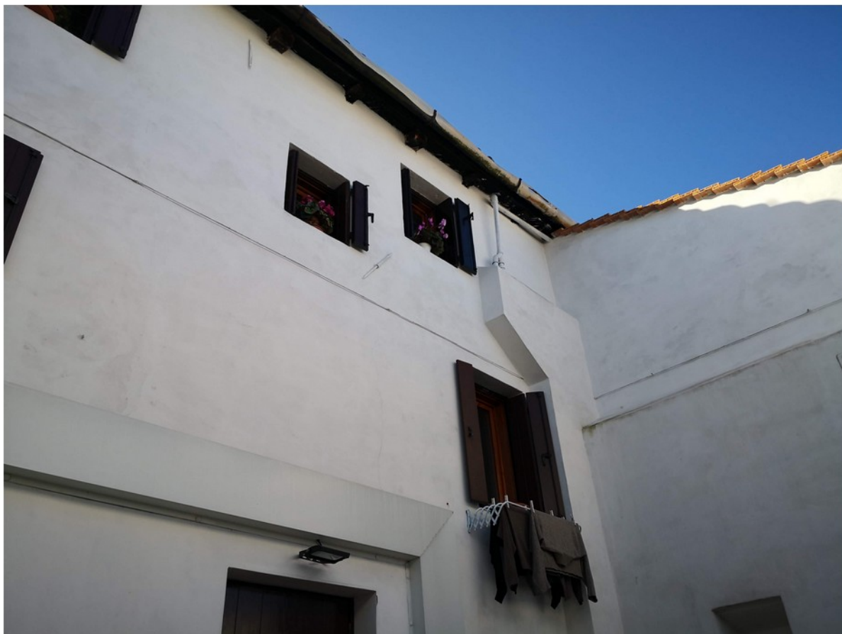
73 - facciata interna nord
