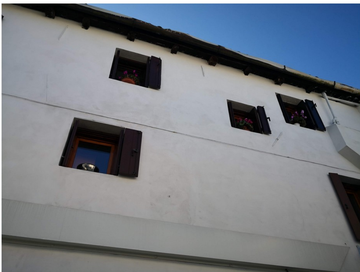
72 - facciata interna nord
