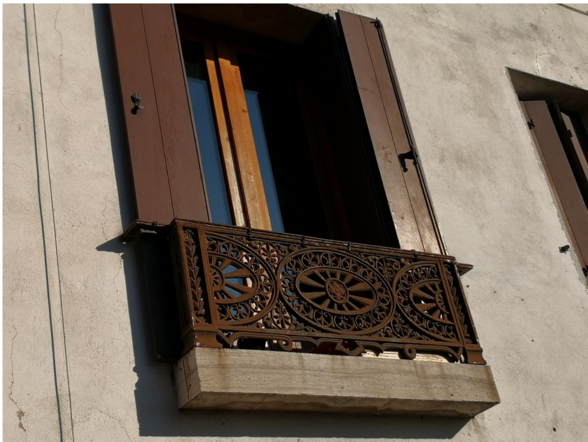
63 - particolare ringhiera fronte
