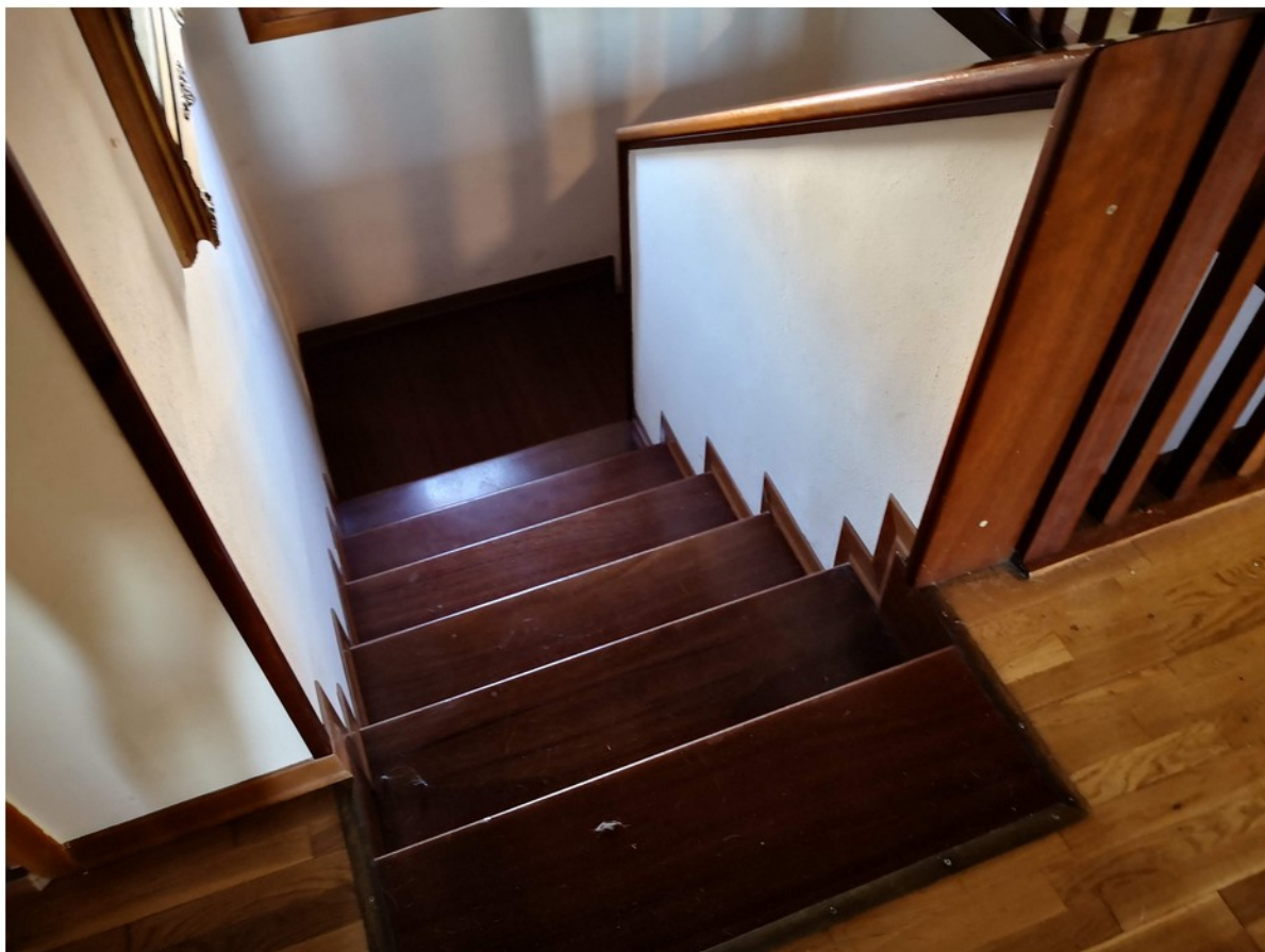
55 - particolare scale piano secondo
