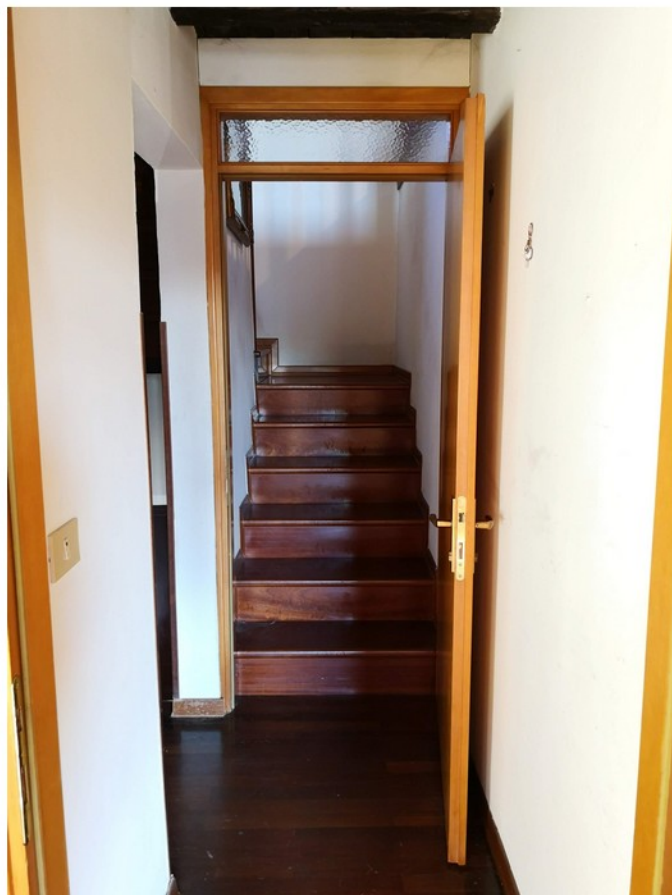
57 - vano scala piano primo
