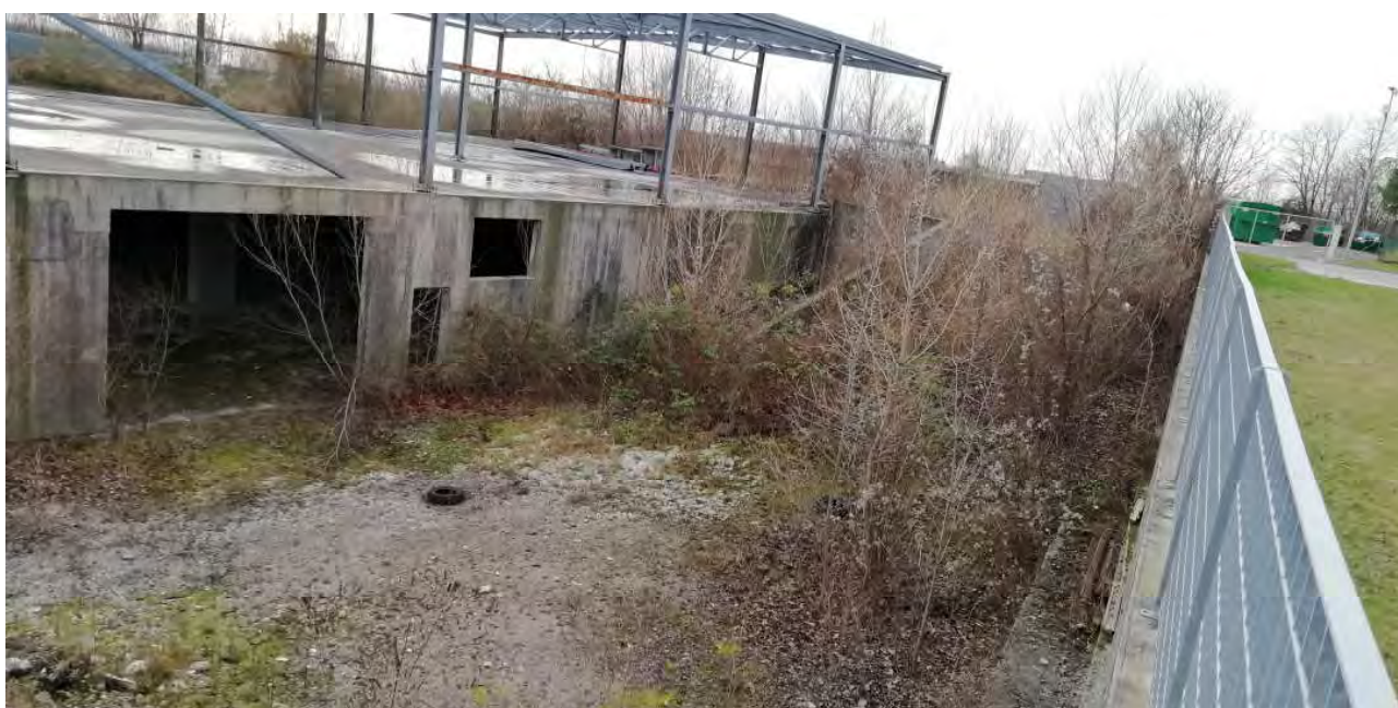
Vista entrata parte interrata lato nord e rampa di accesso
