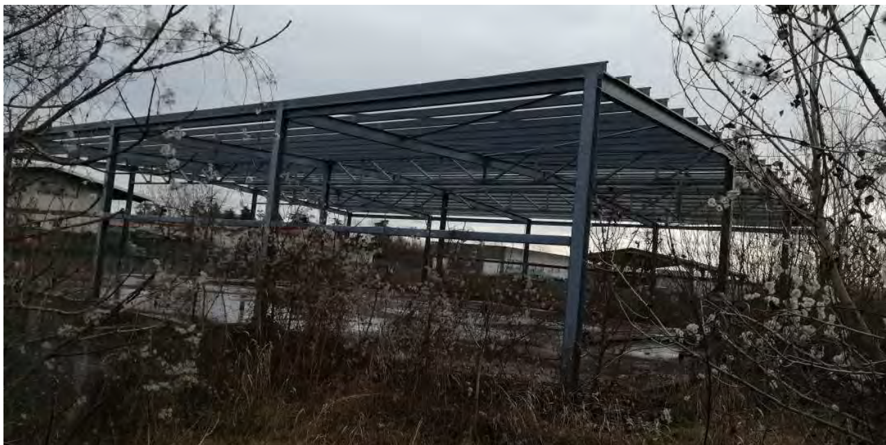
Vista lato nord
