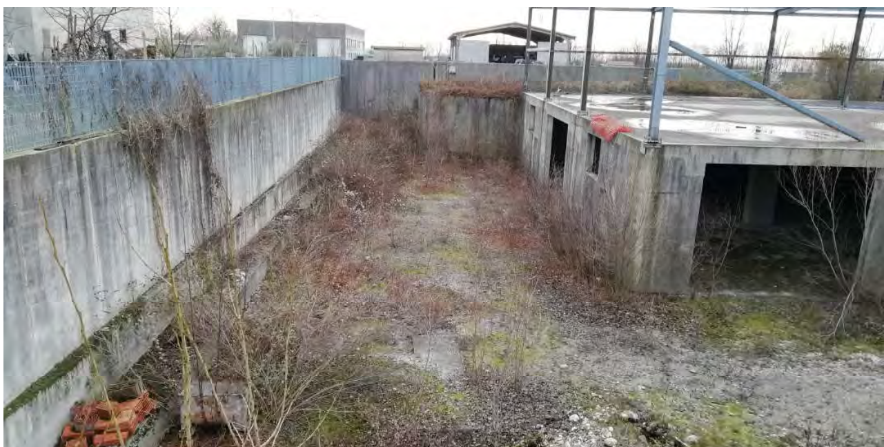
Vista entrata parte interrata lato nord e est
