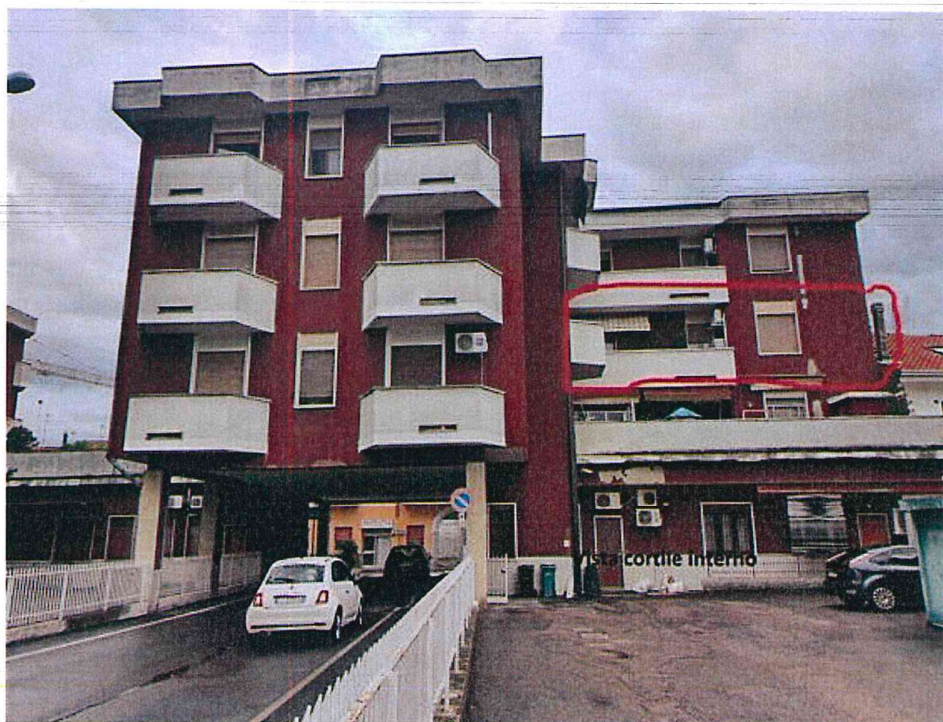
Fotografia G.13 - vista esterno da ovest
