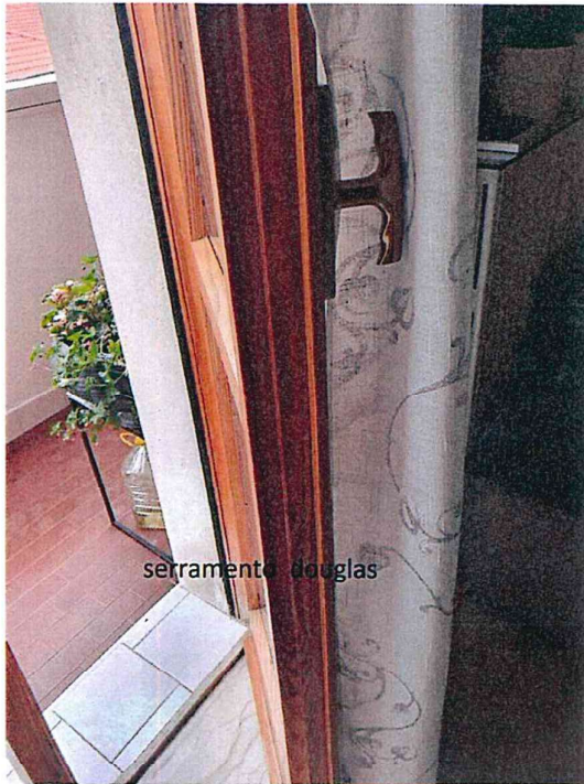
Fotografia G.8 - particolare serramento
