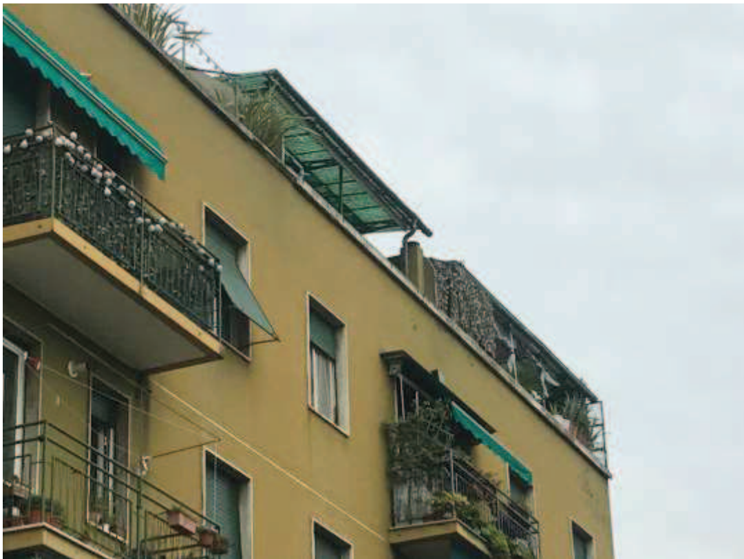
Immagine 3. Il fabbricato inquadrato da via Rho, dettaglio della posizione dell'unità immobiliare.
