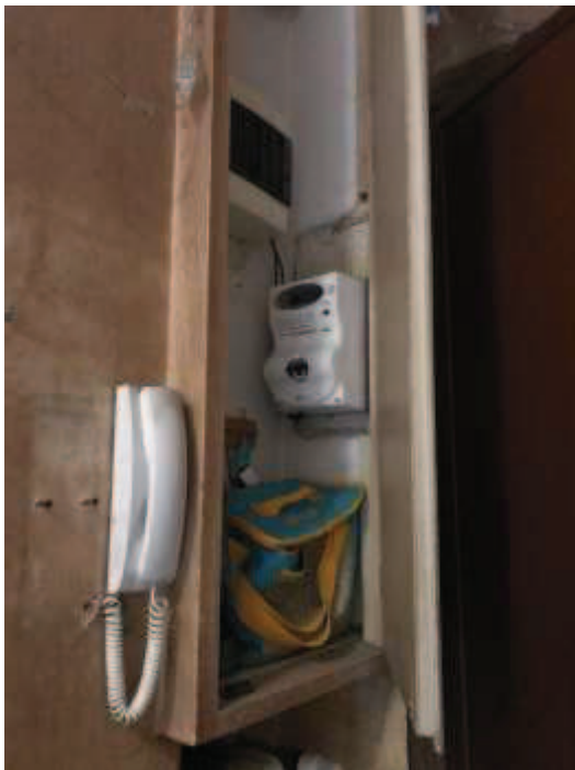
Immagine 14. Dettaglio della collocazione di contatore elettrico e citofono, accanto all'ingresso.
