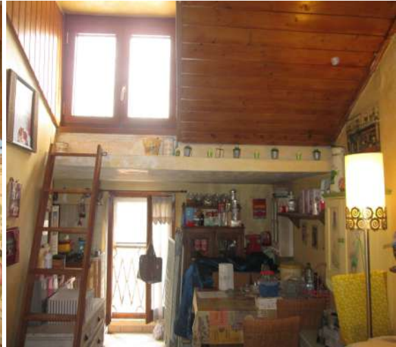
vista del solaio lato corte interna
