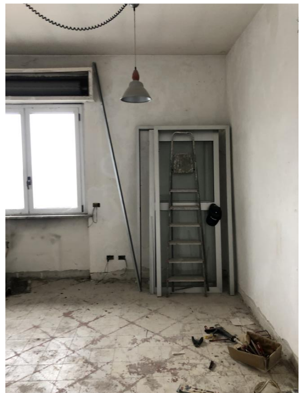
Viste locali piano primo da ristrutturare
