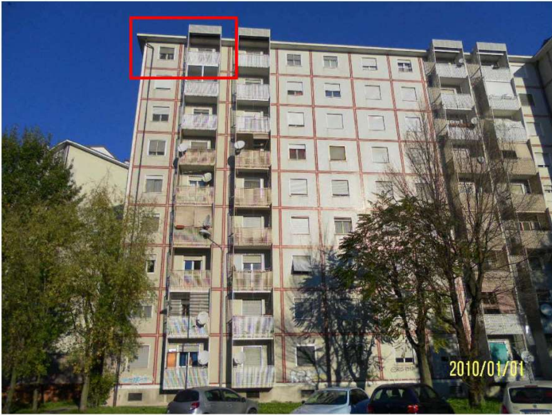
Foto n. 15: Prospetto sul retro.
