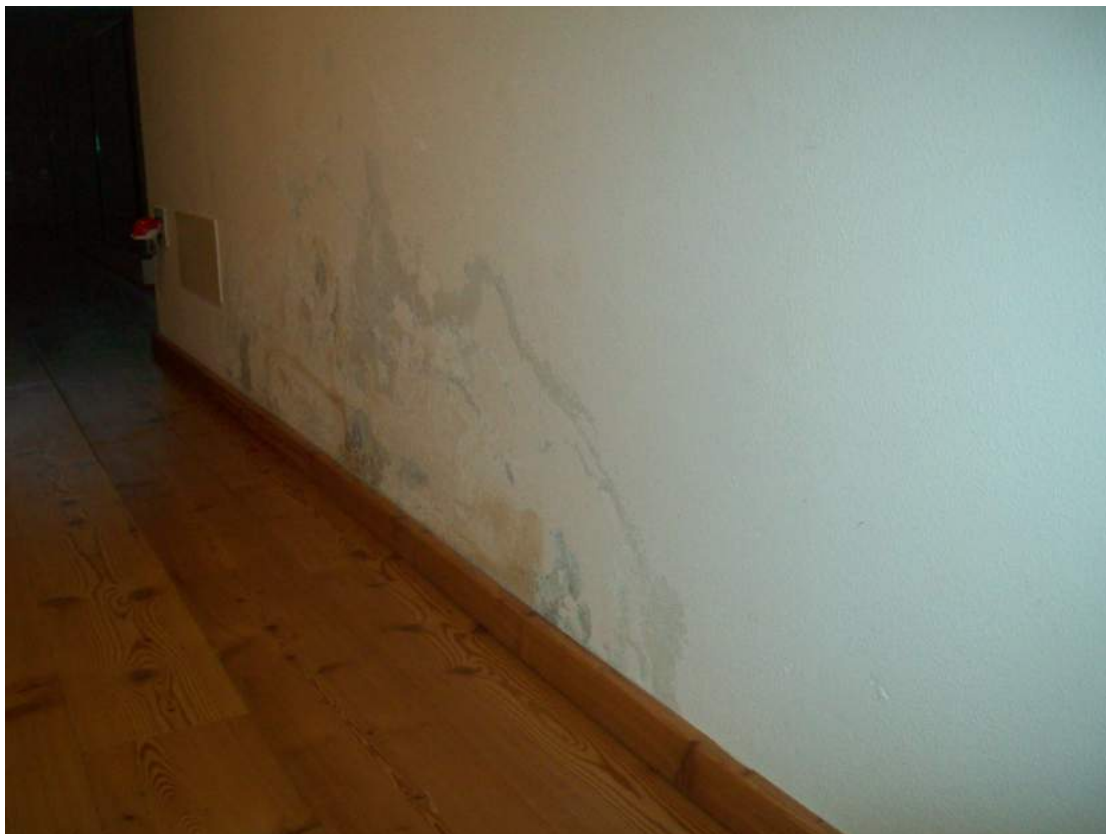
Foto 14: Divisorio disimpegno bagno primo piano
