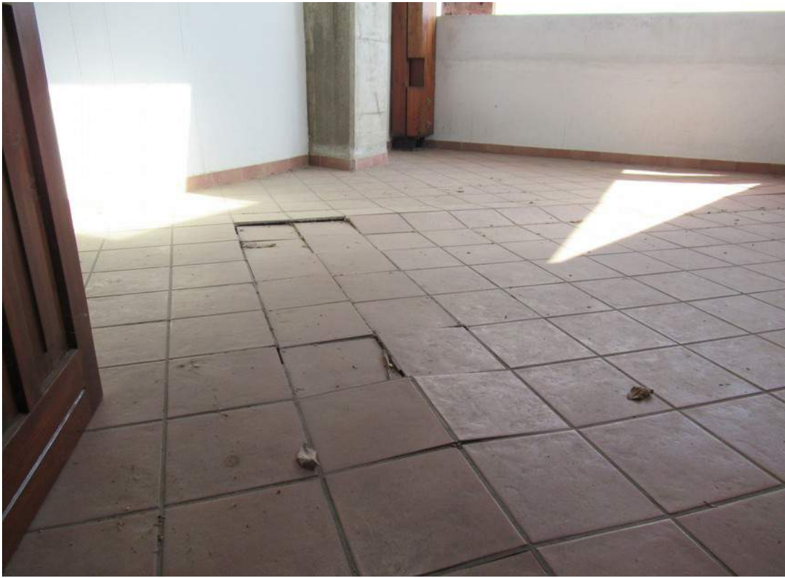
Foto 19: Particolare pavimento terrazzo primo piano
