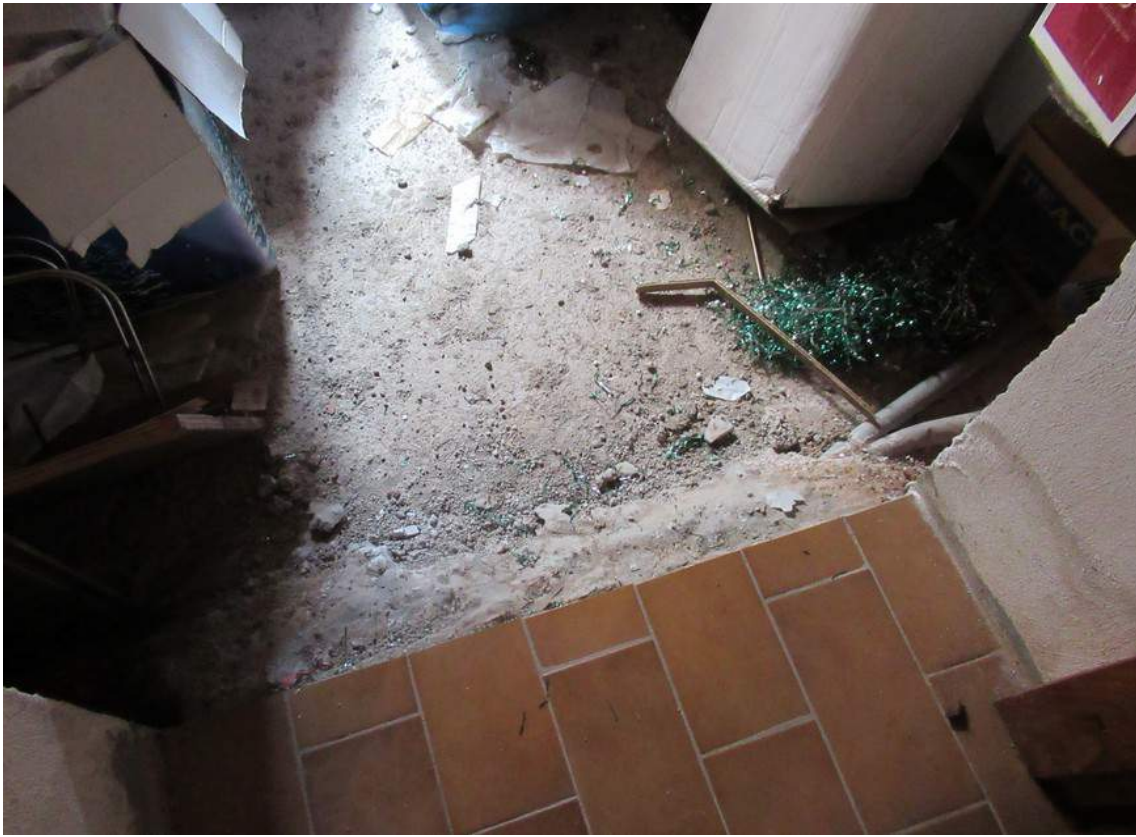
Foto 17: Accesso alla soffitta
