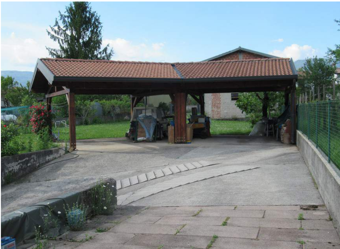
Foto 4: Tettoia vista da Sud
