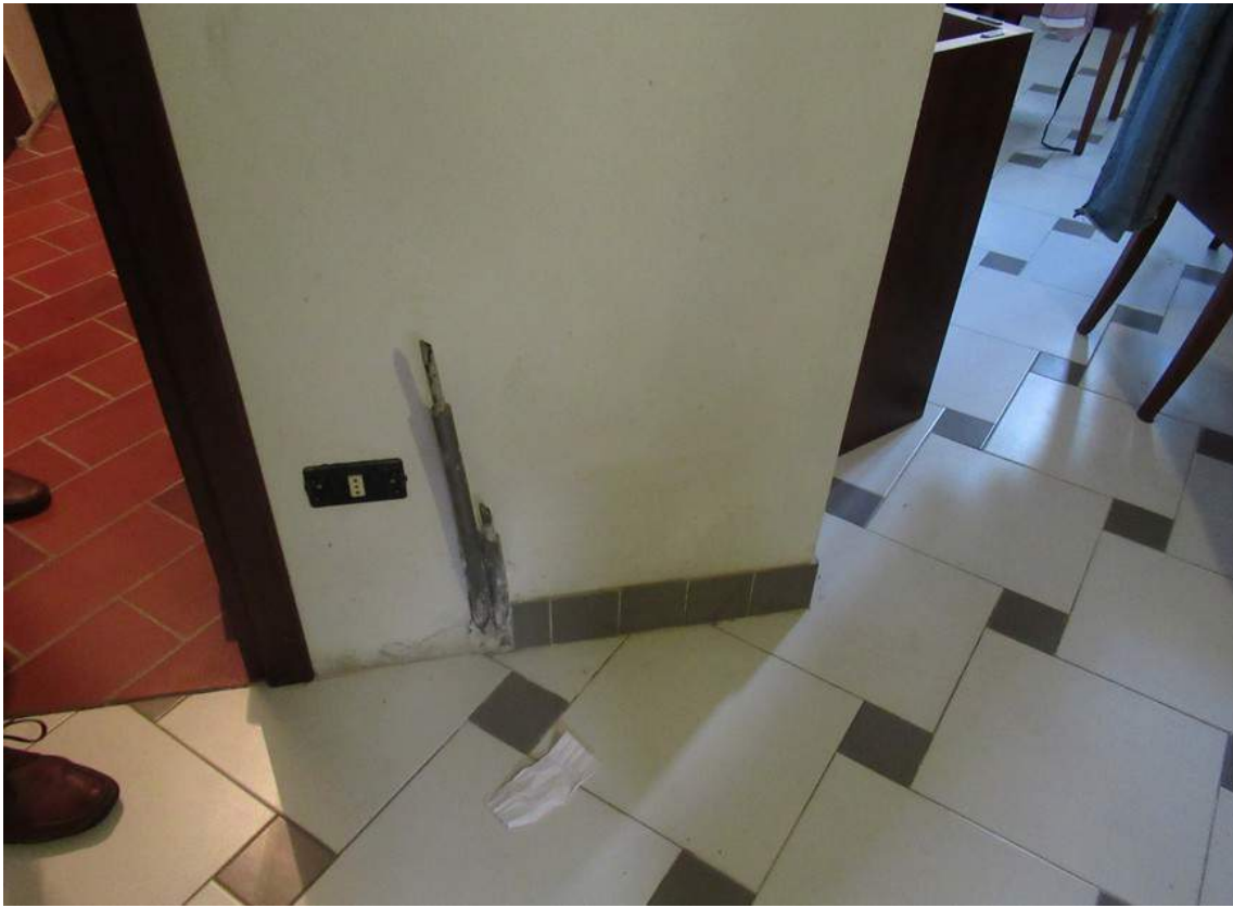
Foto 23: Pavimento taverna disimpegno
