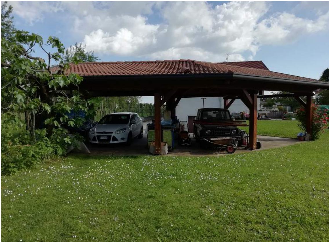
Foto 5: Tettoia vista da Nord
