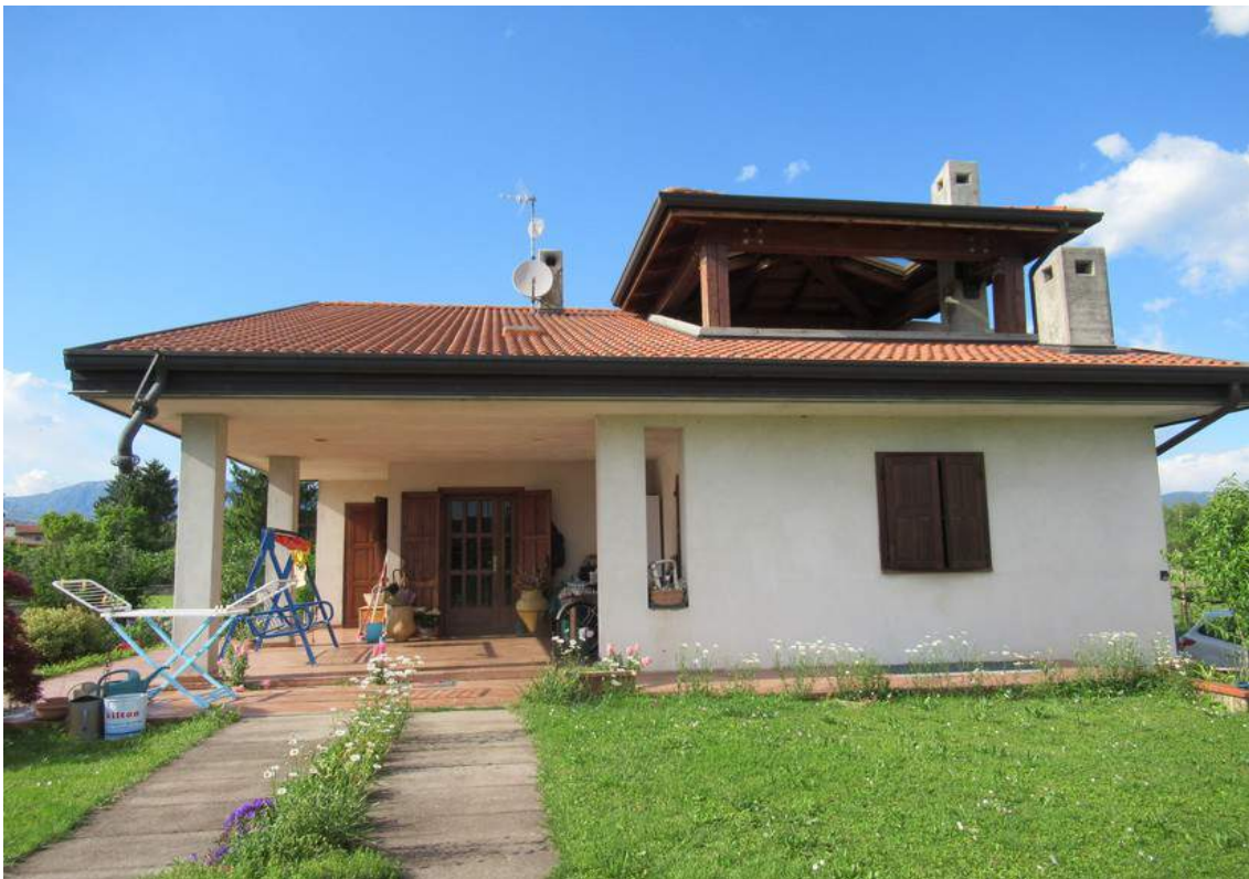
Foto 1: Vista abitazione da Sud
