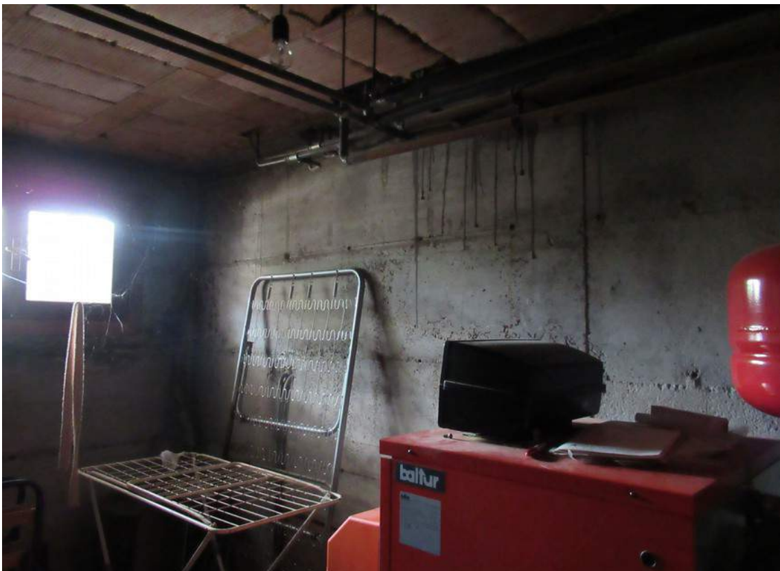
Foto 26: Vano Centrale termica
