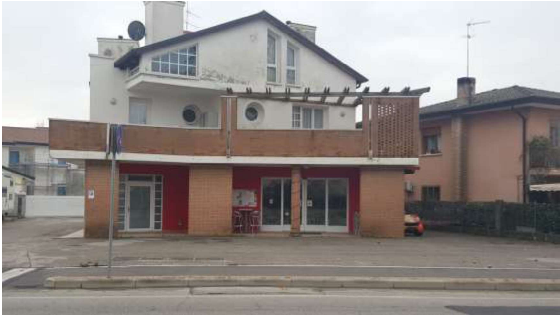
Vista da Viale Trieste – fronte nord
