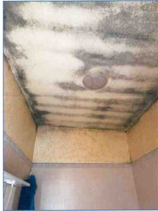
Foto 38 - dettaglio muffa
