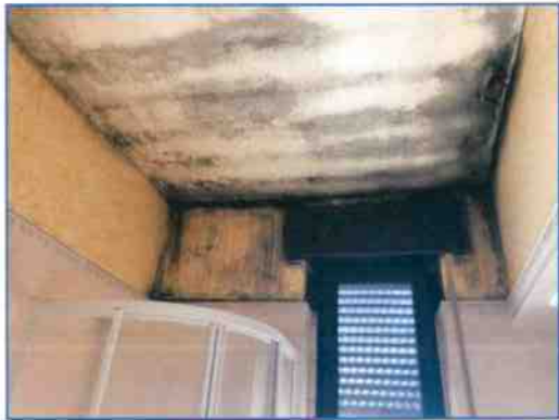
Foto 41 - dettaglio muffa
