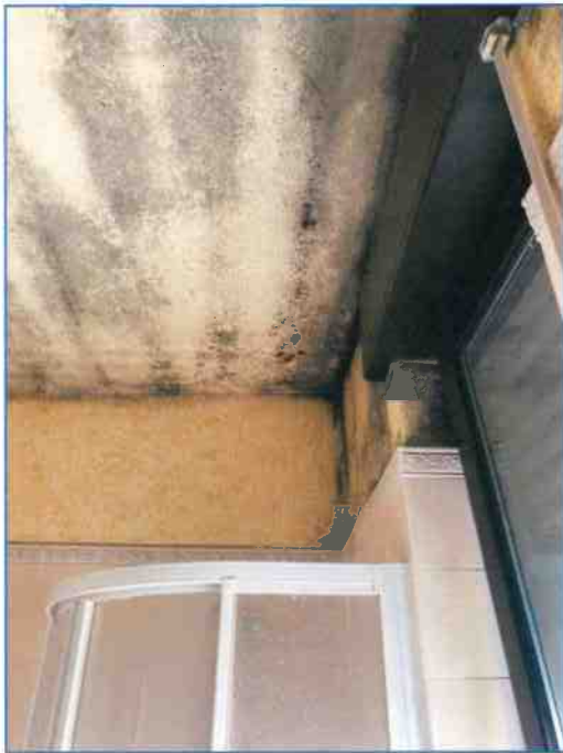
Foto 37 - dettaglio muffa
