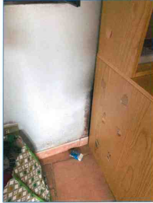
Foto 40 - dettaglio muffa
