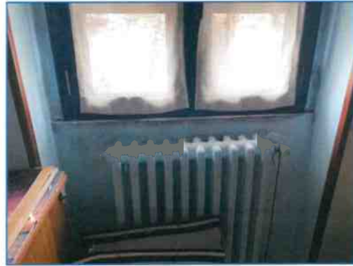
Foto 42 - dettaglio muffa
