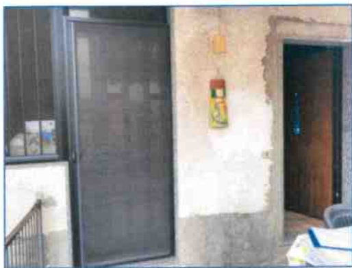
Foto 11 - ingressi da ballatoio comune
