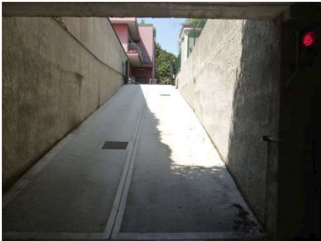
FOTO 3 - Rampa di ingresso ai box
