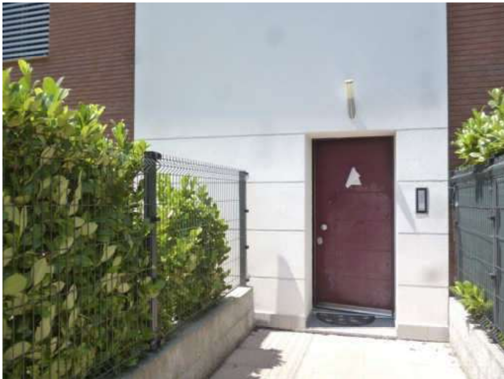
FOTO 2 - Ingresso all' edificio scala B dal vialetto condominiale
