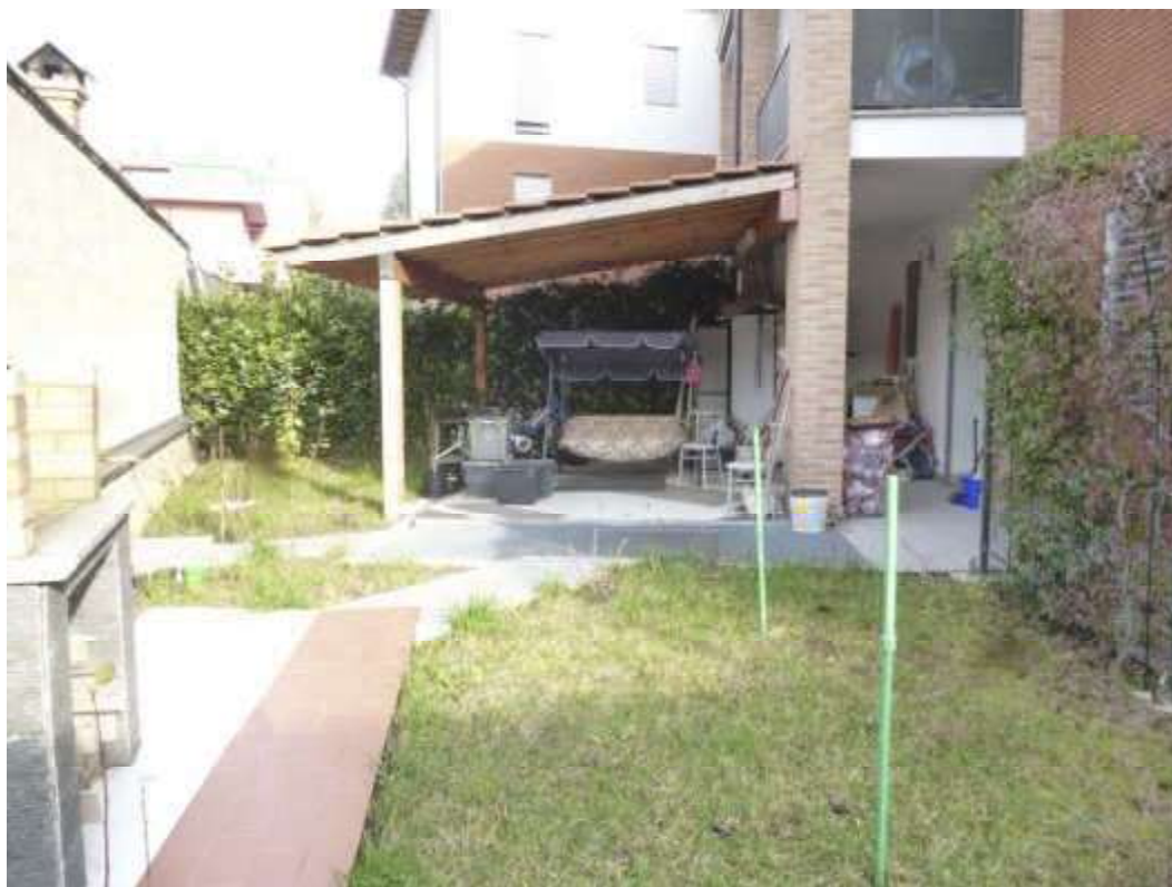
FOTO 13 - Tettoia realizzata su giardino di pertinenza lato porticato cucina
