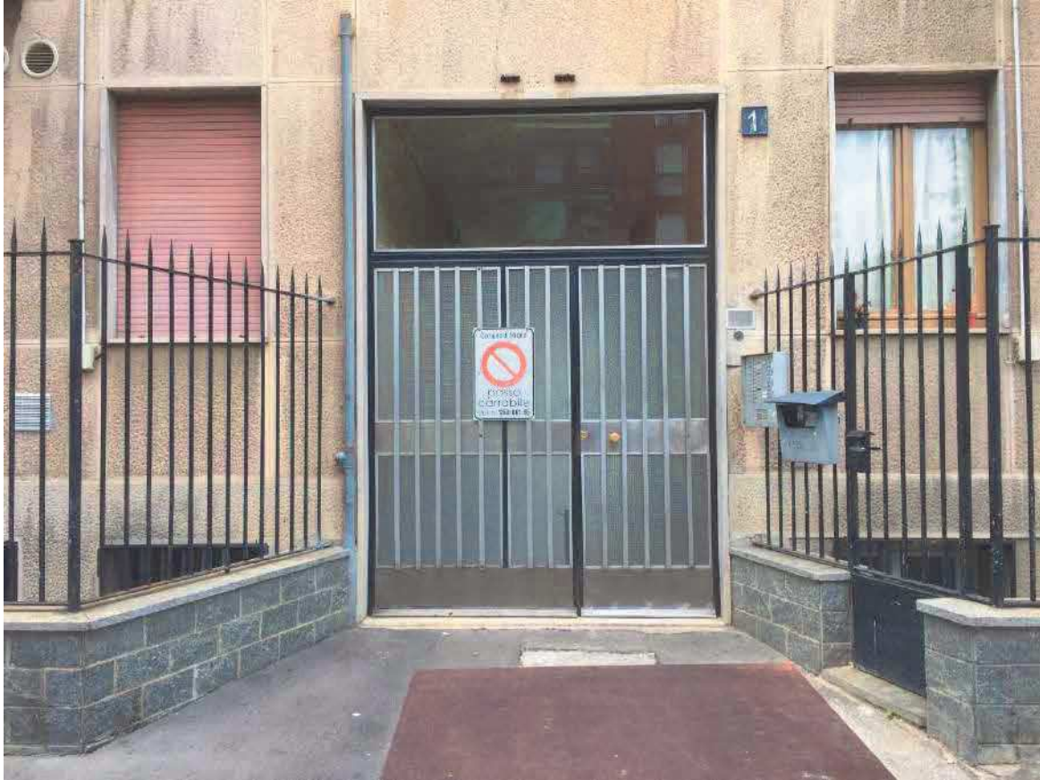
Foto 05 - Accesso al fabbricato al civico 1 di via Angelo Del Bon
