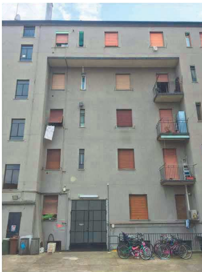
Foto 04 - Il fabbricato e il cortile interno comune
