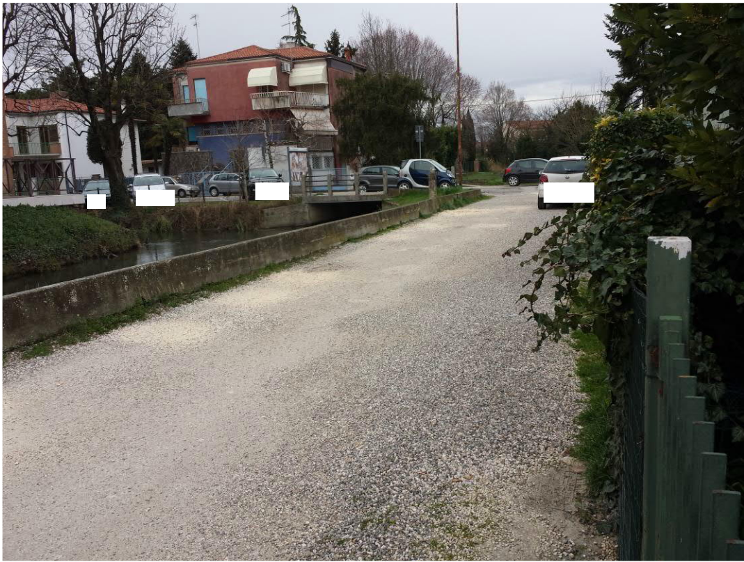
Strada retrostante su area demaniale (accesso carraio non autorizzato)
