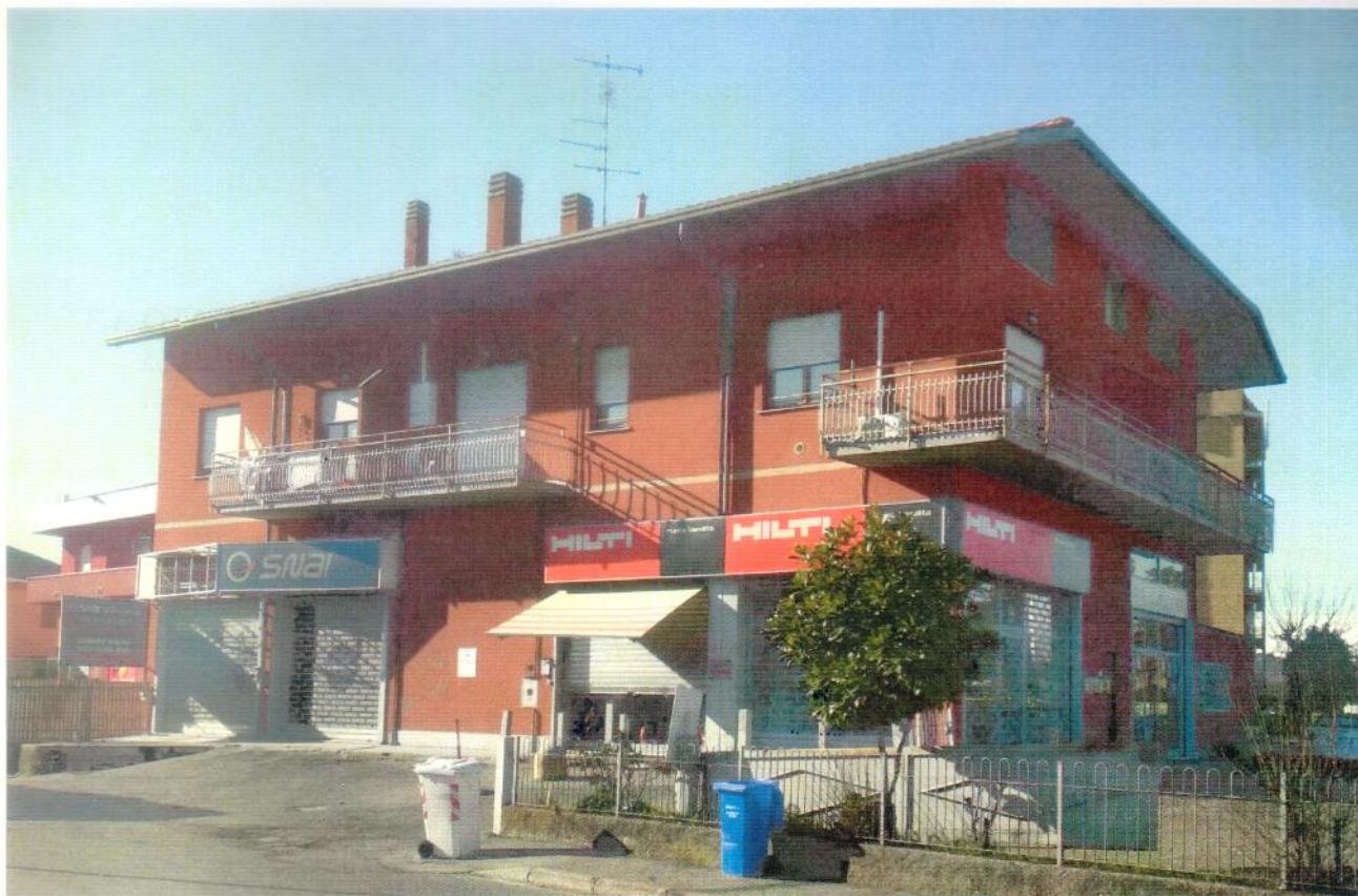
Foto n. 1 – Prospetto del fabbricato
