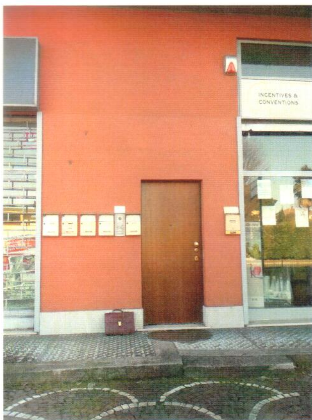
Foto n. 2 – Ingresso al condominio
