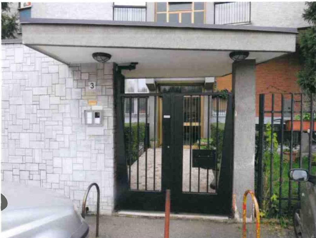
CANCELLO PEDONALE DI INGRESSO AL COMPLESSO IMMOBILIARE
