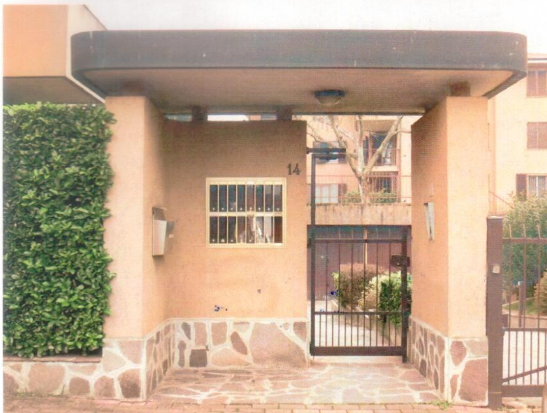
Portoncino di ingresso pedonale al complesso immobiliare
