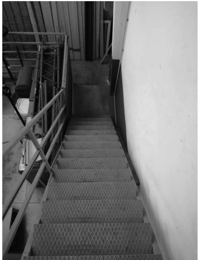
scala d'accesso piano primo
