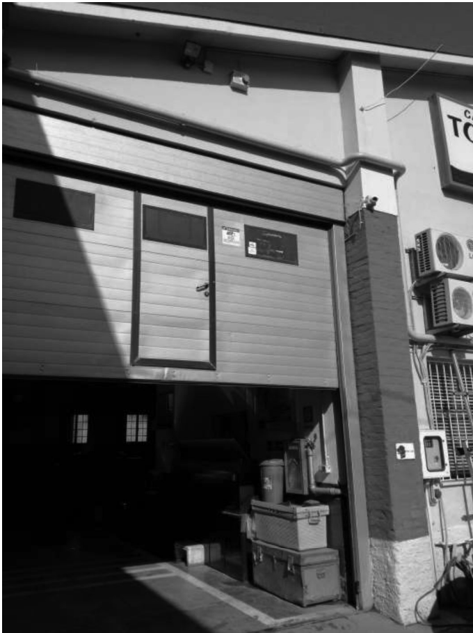
Foto 6,7 - foto esterne del civico 44 interno – portone ingresso e pavimentazione
