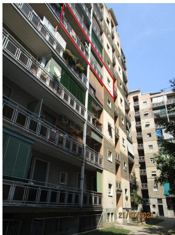
Foto 4 – Vista e inquadramento dal cortile interno
