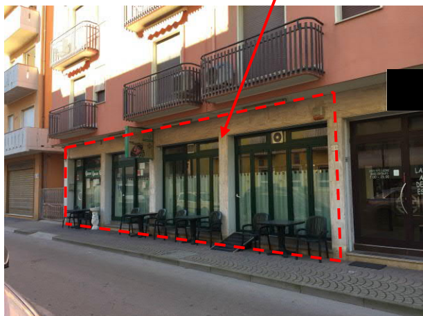
prospetto sud immobile commerciale visto dalla strada Via G. Marconi n. 58
