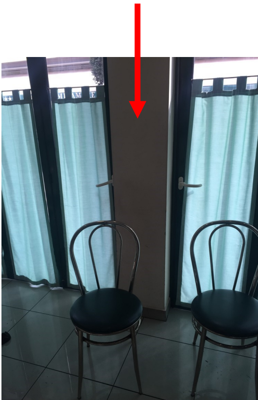
difformità catastale e di progetto dei pilastri e di una parete in prossimità alle vetrate dell'immobile commerciale
