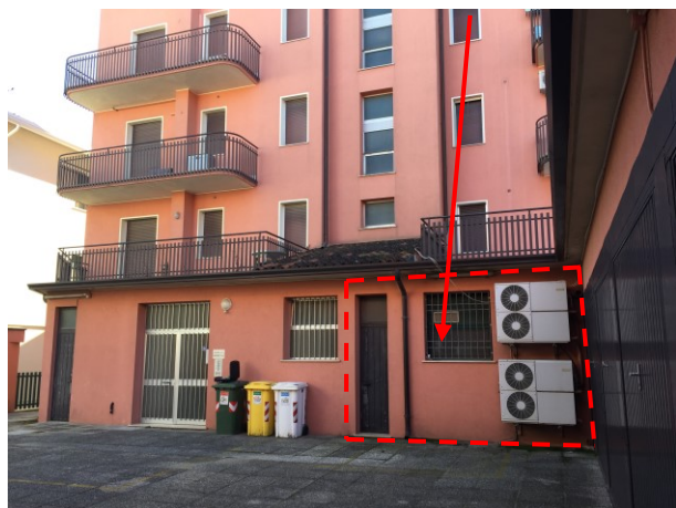
prospetto nord retro fabbricato dell'immobile commerciale
