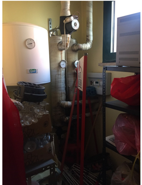
vista interna ripostiglio
