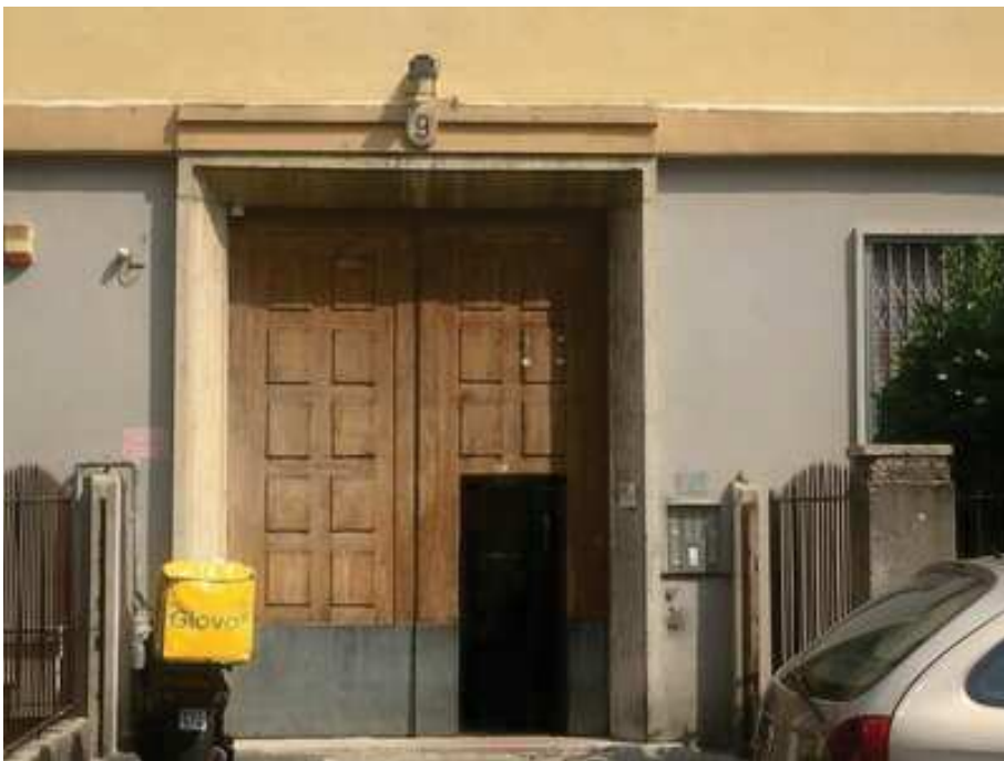
Esterno – Civico su via Cacciatori
