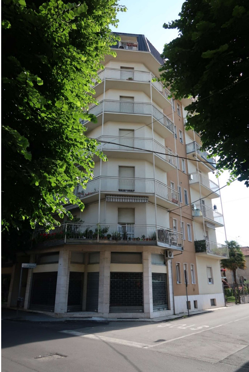
FACCIATA SU STRADA
