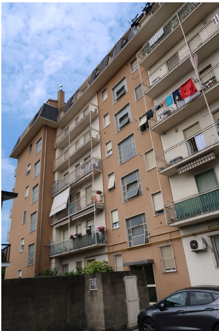
FACCIATA SU CORTILE INTERNO
