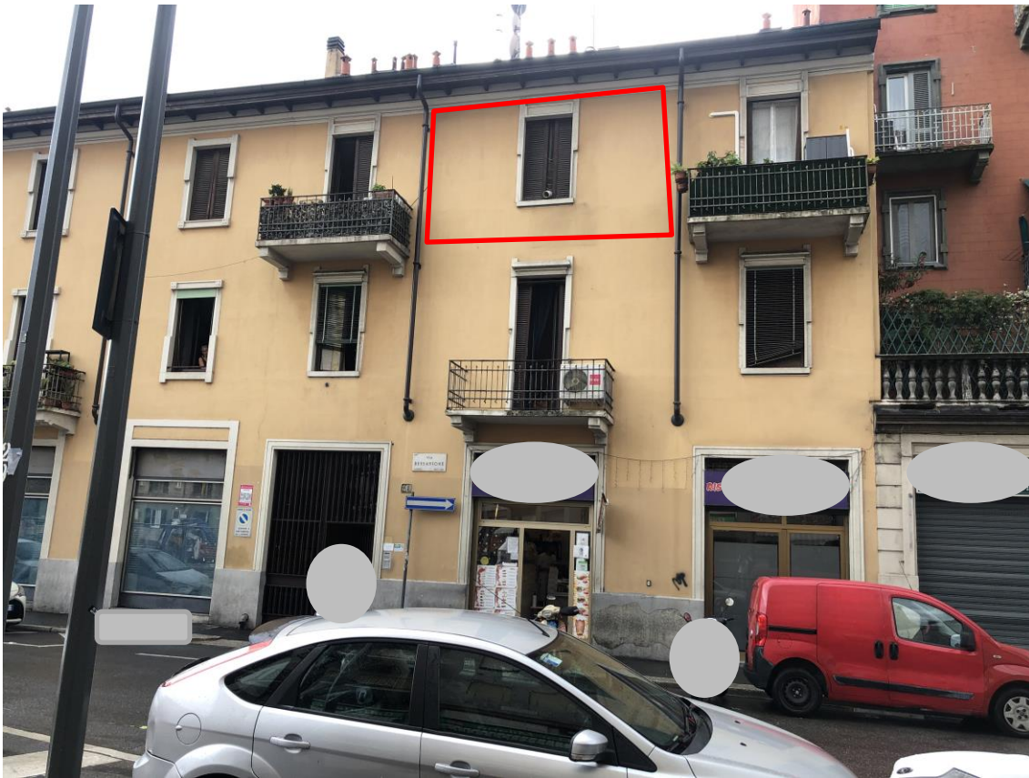
Viste dello stabile da Via Bessarione
