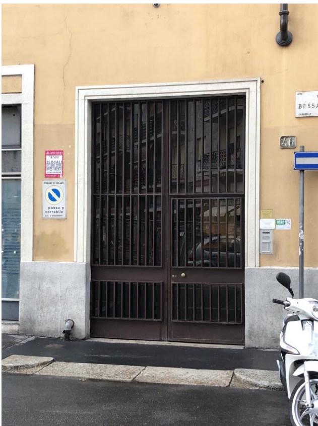
Vista portone di ingresso allo stabile
