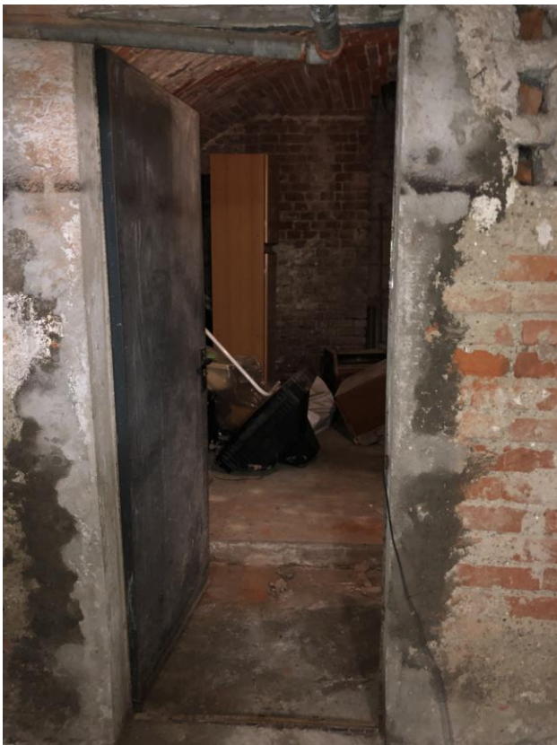
Vista porta cantina di pertinenza
