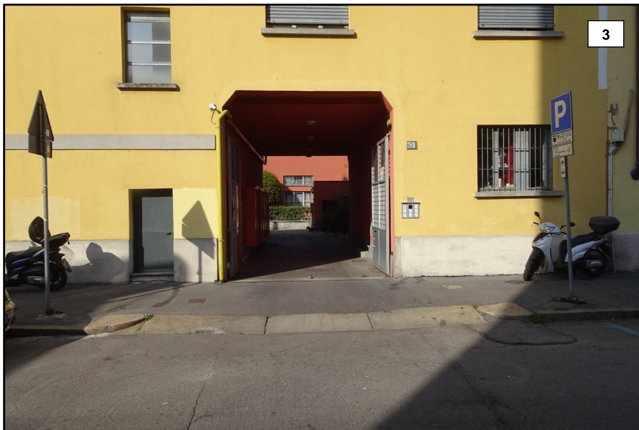
LOTTO A - INGRESSO COMUNE COMPLESSPO (visto da strada)
