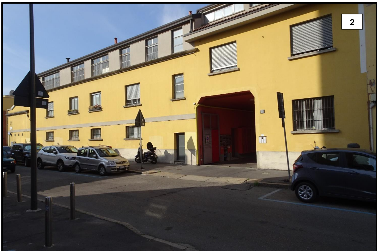
LOTTO A - VISTA ESTERNA DA VIA COMUNE ANTICO
