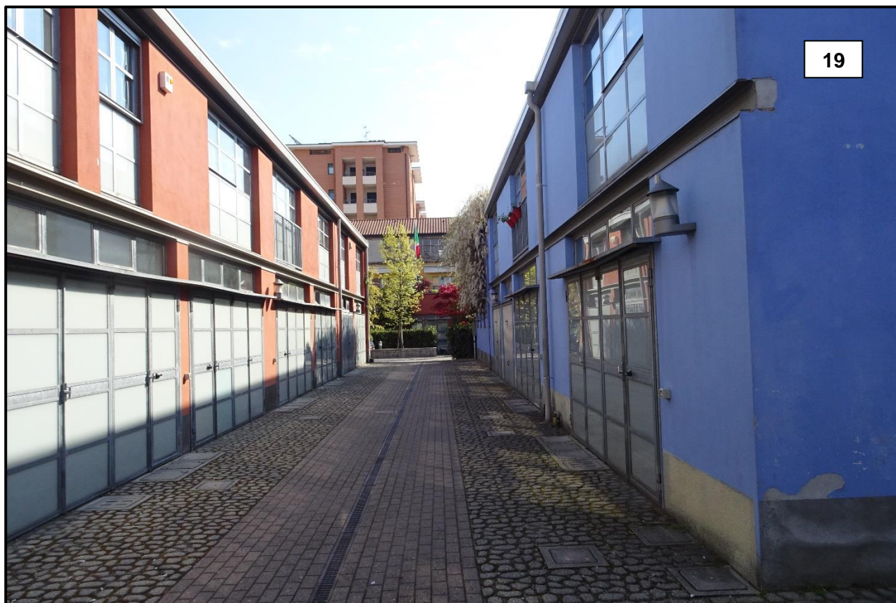
LOTTO B - AREA CORTILIZIA CARRABILE DI ACCESSO AL BOX (vista verso androne)
