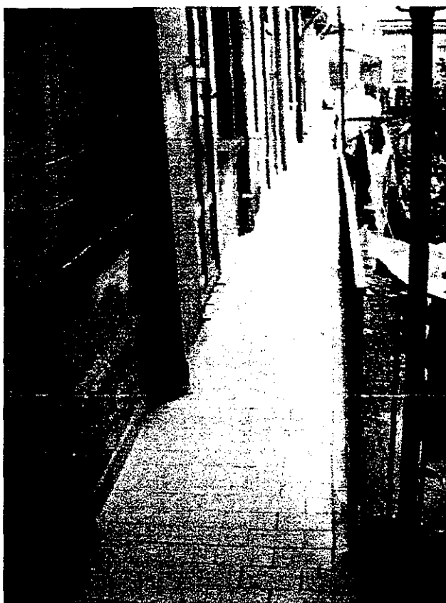
Particolari dei ballatoi e di alcune puntellature, realizzate con profilati "tipo innocenti", applicate ad alcuni tratti degli aggetti della struttura del tetto.
