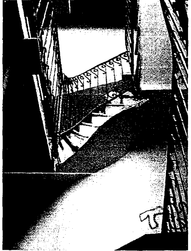
Particolari dei gradini in pietra di serizzo e delle balaustre in ferro battuto rilevati nel vano scala; assenza d' impianto ascensore e degli estintori segnalati.
