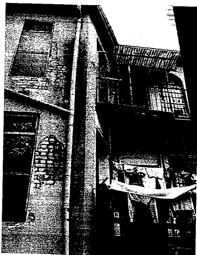
Particolari dei ballatoi realizzati in struttura di ferro (travi "IPE") e c.l.s; intonaci in precarie condizioni.
