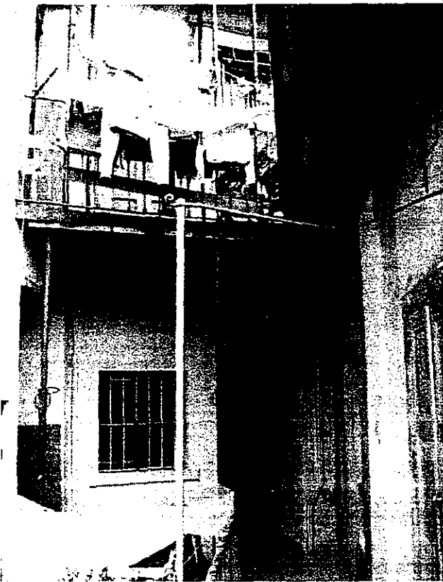
Particolari delle facciate interne rivestite in intonaco e delle pavimentazioni in monocottura rilevate nelle parti comuni; soglie e davanzali realizzati in pietra naturale e cls riconducibili all'età di fabbricazione dell'intero compendio.
