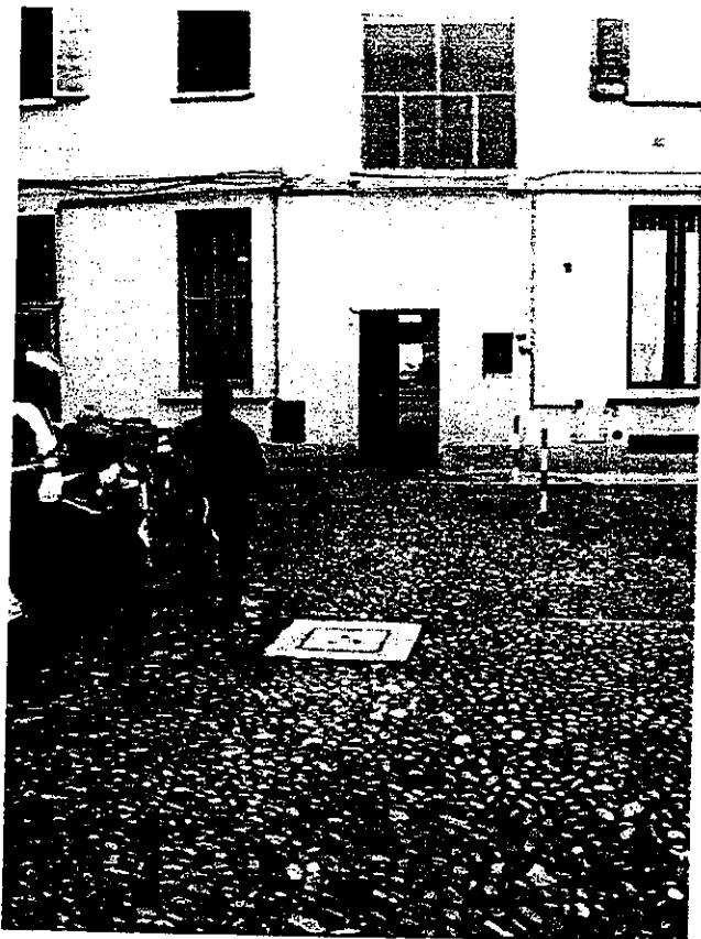
Pavimentazioni in acciottolato su malta rilevate nella corte interna ora occupata da alcune biciclette; accesso al compendio immobiliare anche da via Luigi Torelli n.5 realizzato con portone ligneo.
