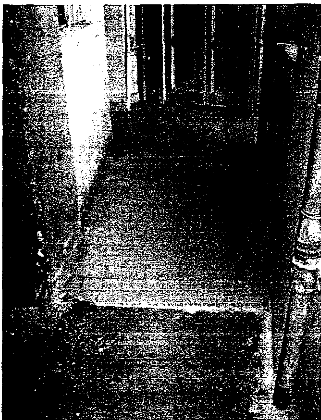
Pavimentazioni e rivestimenti delle parti comuni realizzati in monocottura e battuto di cemento.
