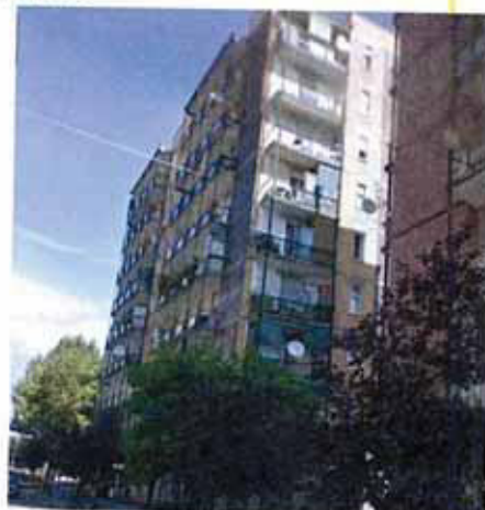
Vista esterna dell'immobile condominiale
