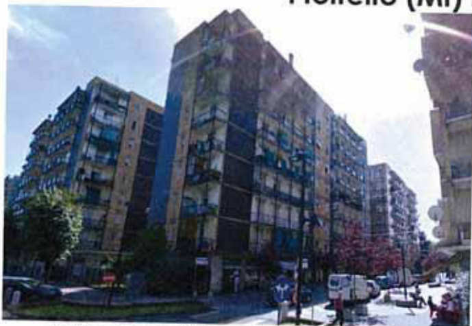
Vista esterna dell'immobile condominiale
