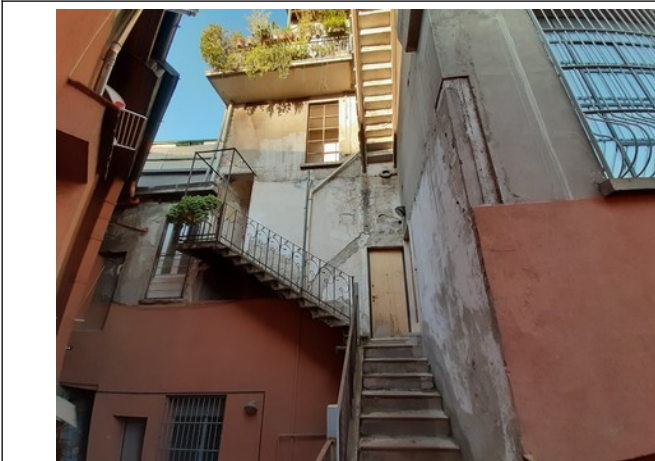
Fig. 5 – Fronte Nord Ovest con scala di accesso
