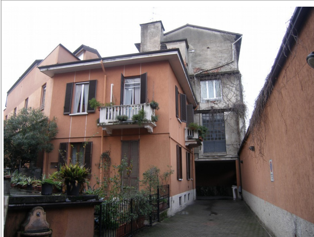
Fig. 3 – Fronte interno verso via Bassano del Grappa
