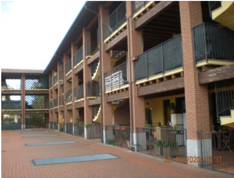
Facciata lato ingresso
