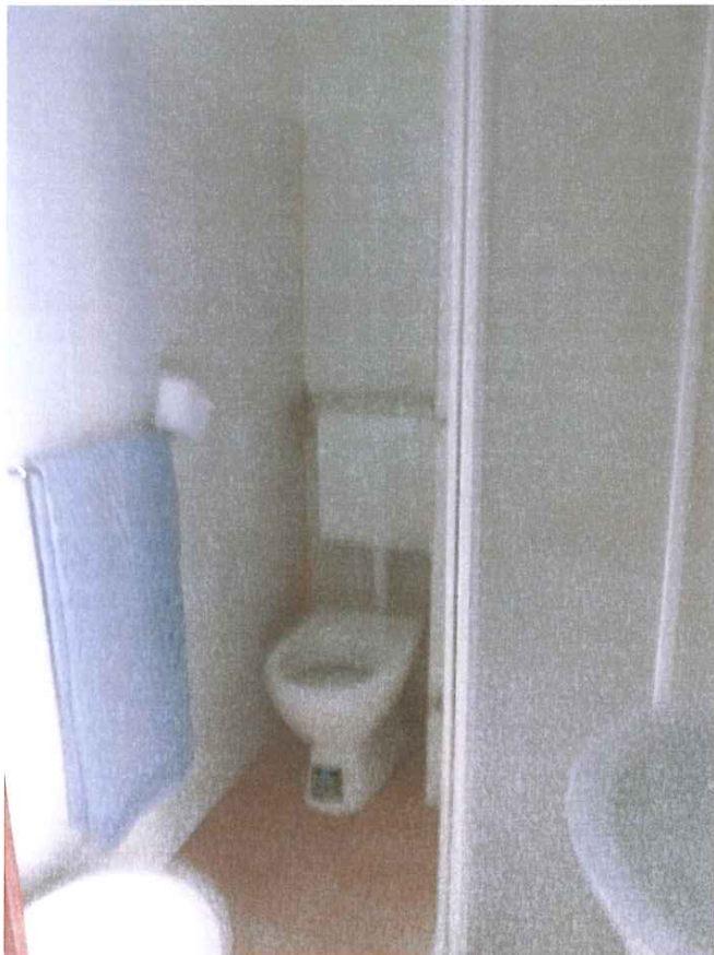
Foto n. 8 Locale bagno servizi
