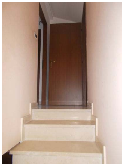
63. Scala di arrivo al piano sottotetto
