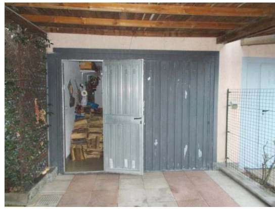
8. Ingresso al sub 2
