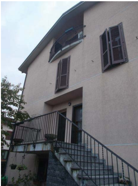
13. Facciata ovest con scala di ingresso
