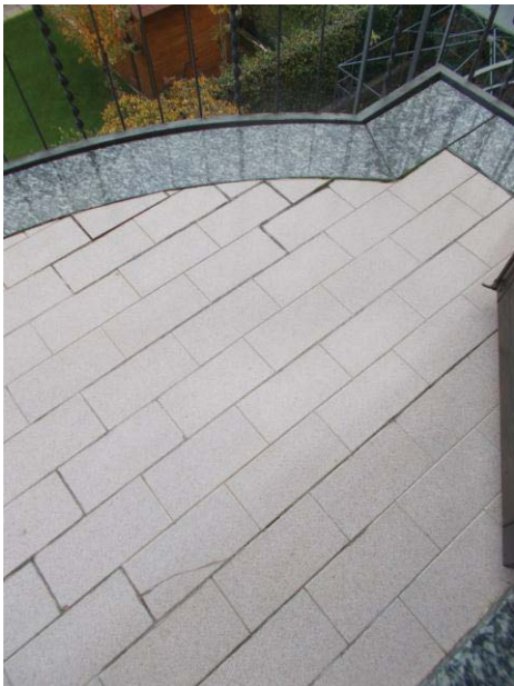
45. Pavimentazione del balcone
