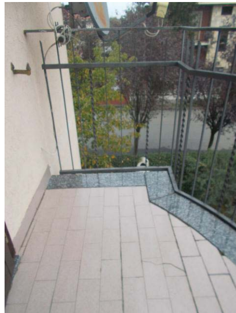
46. Pavimentazione del balcone
