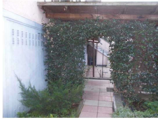
6. Passaggio verso il box (sub 2)
