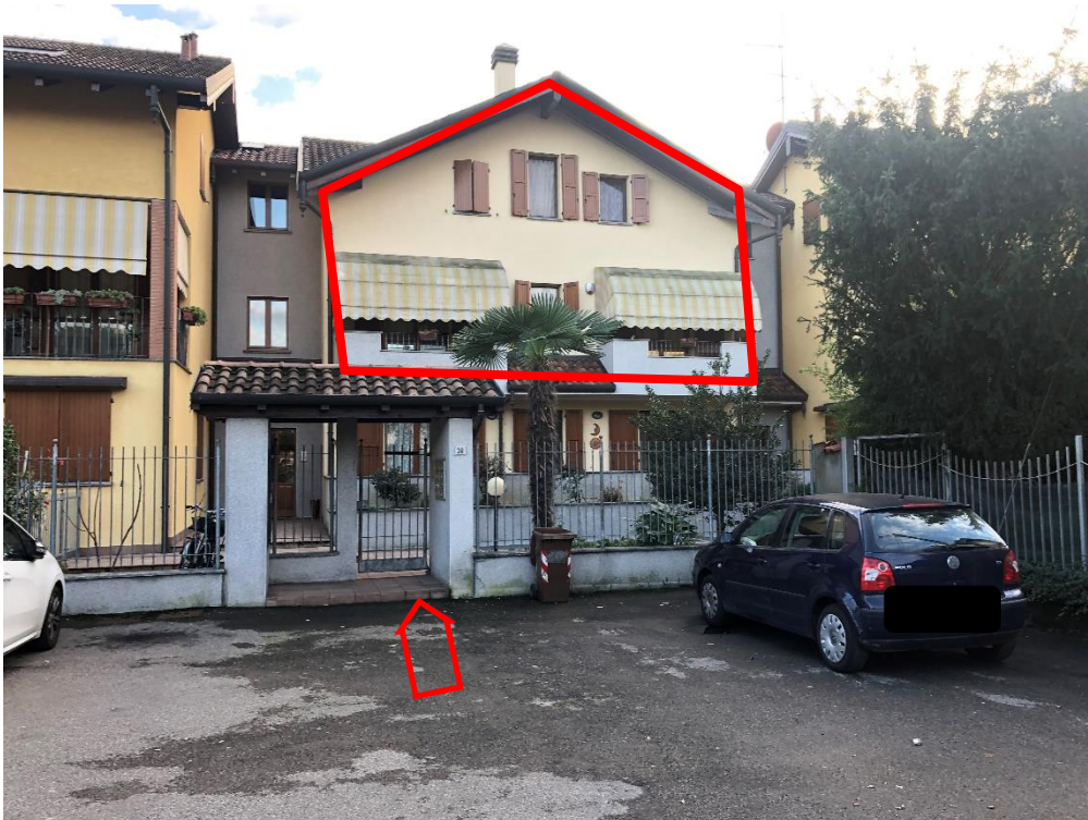
Vista del fabbricato
