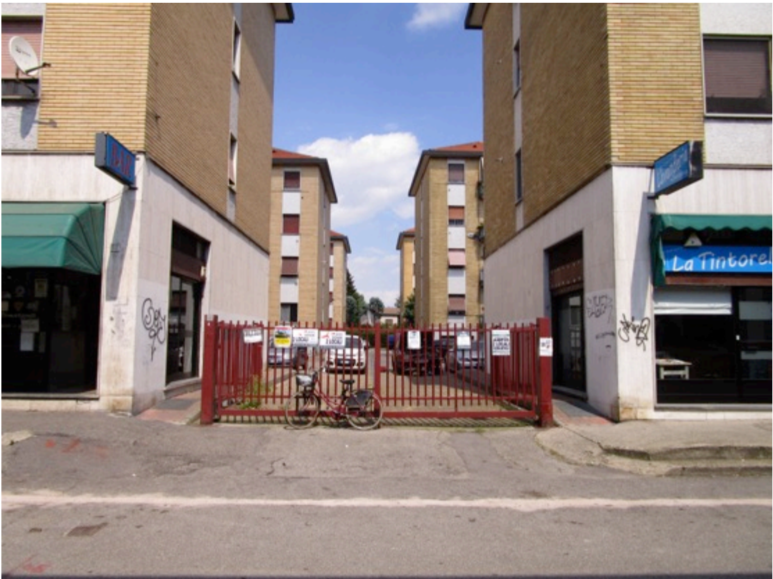
5. Accesso pedonale e carroia dalla Via Monzese 48/50.
