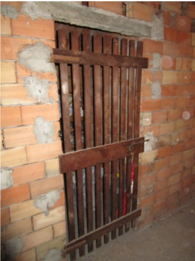
27. Porta di accesso al solaio.
