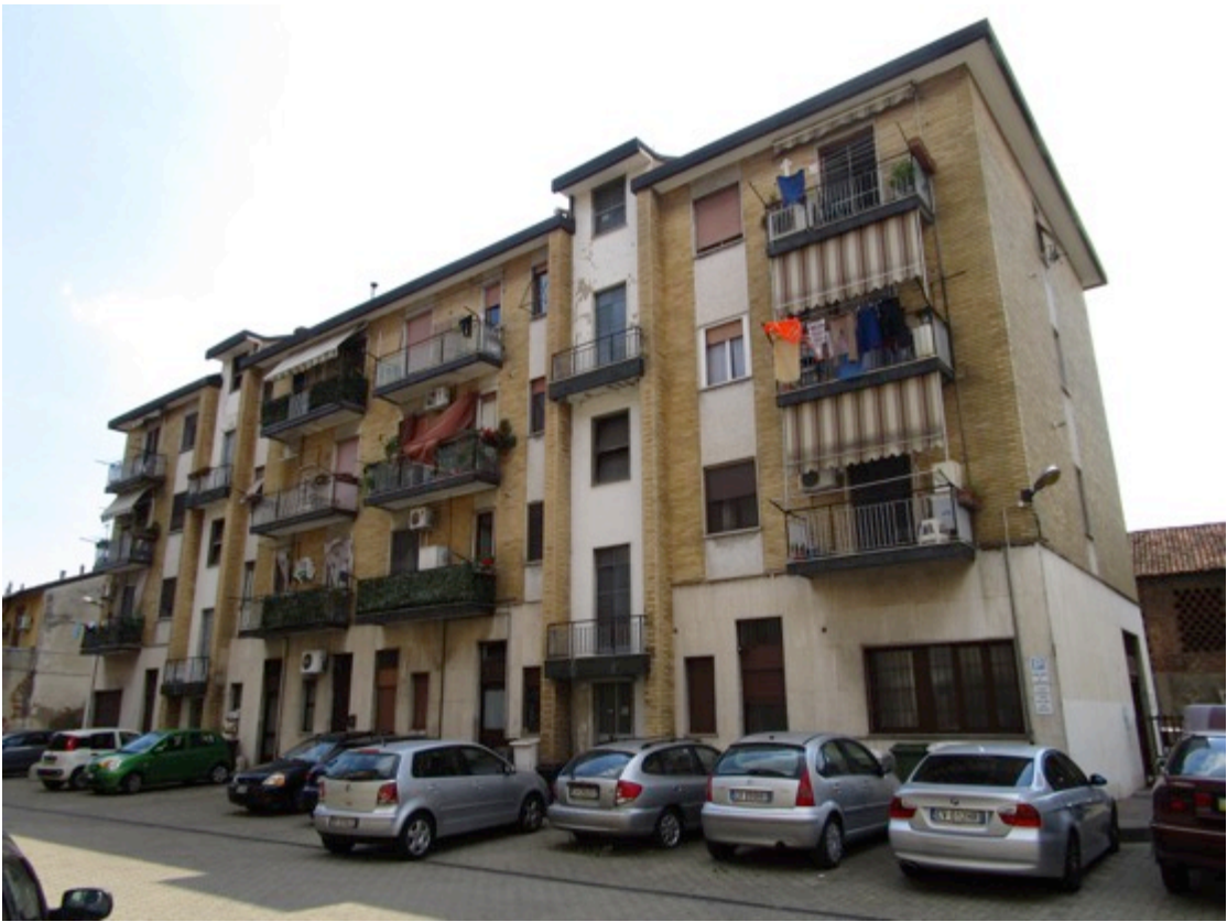
3. Fabbricato fronte strada di Via Monzese 46, vista lato est.
