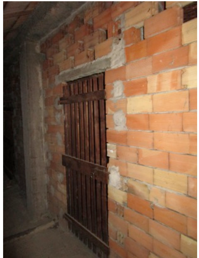
28. Porta di accesso al solaio.
