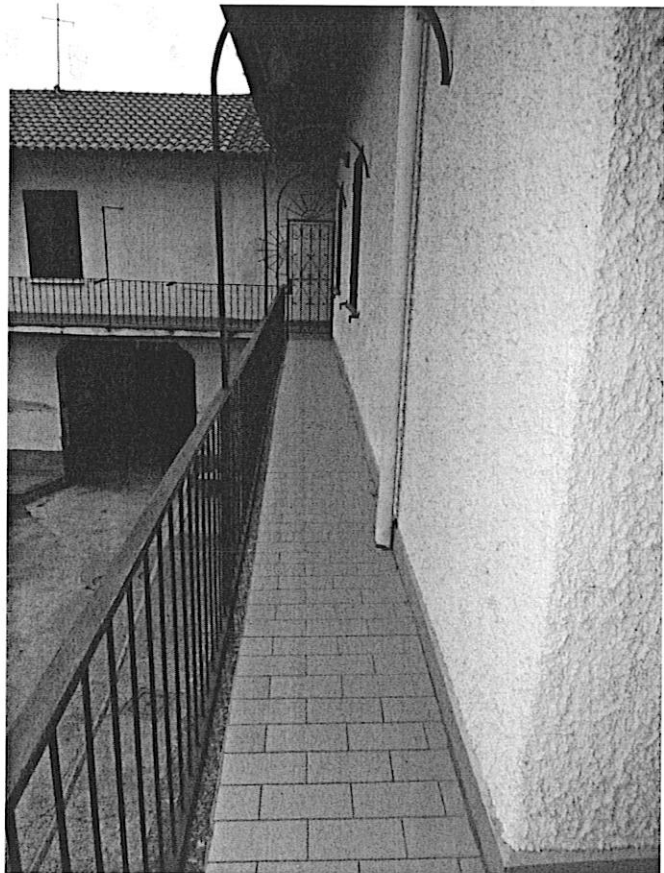
CORPO " A " - PIANO PRIMO - BALLATOIO
