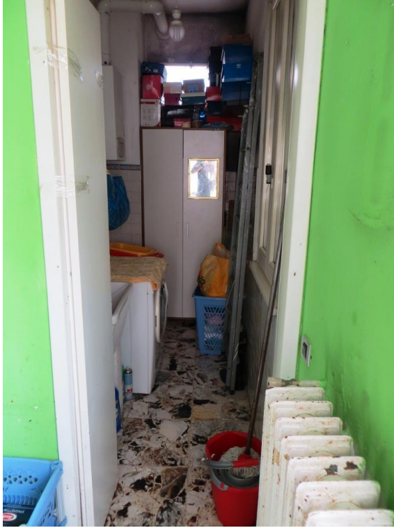
Foto 20 - ripostiglio della cucina
