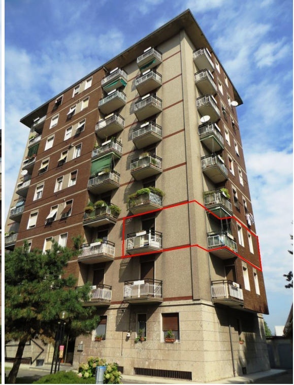
Foto 4 - ingresso all'androne e localizzazione dell'unità immobiliare al 2° piano
