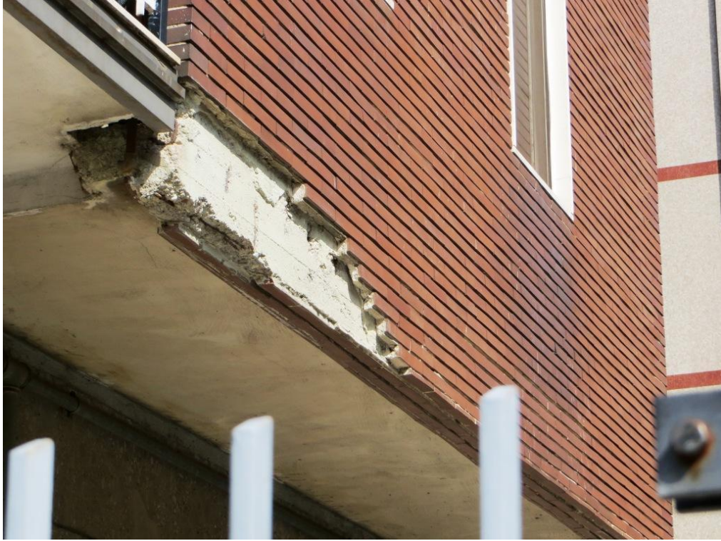
Foto 5 – stato di manutenzione conservazione di alcune parti di facciata
