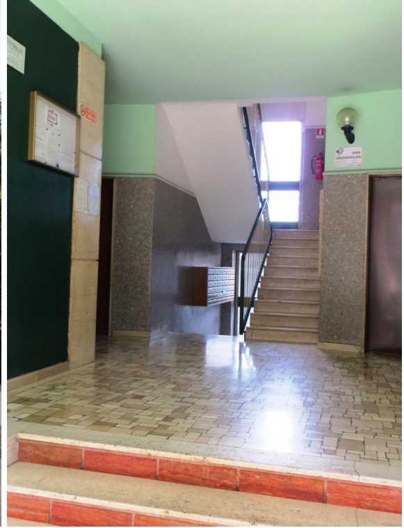
Foto 8 - androne e vano scala
