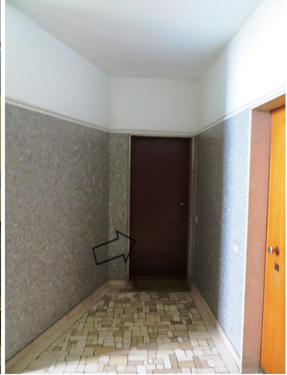
Foto 12 - ballatoio e ingresso unità immobiliare
