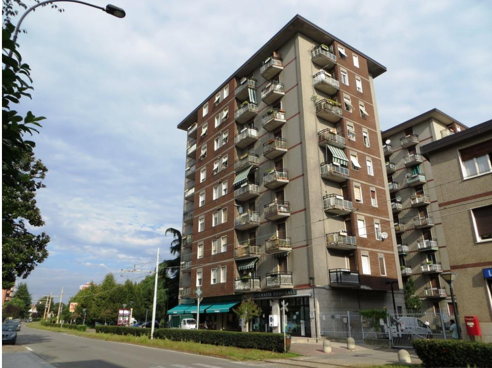
Foto 2 – ingresso al condominio da Via dei Mille 117
