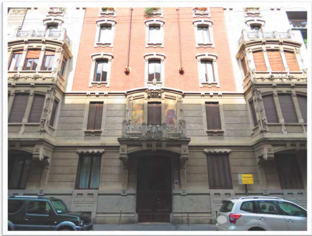
Particolari della facciata.
