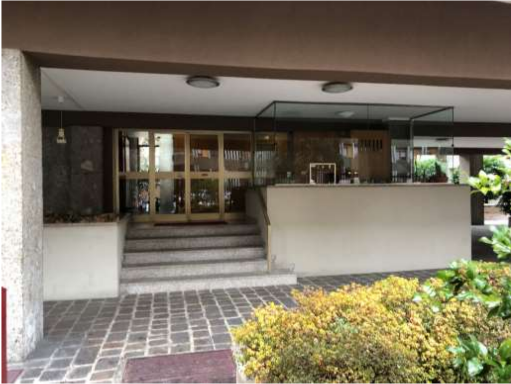
Vista ingresso principale e guadiola
