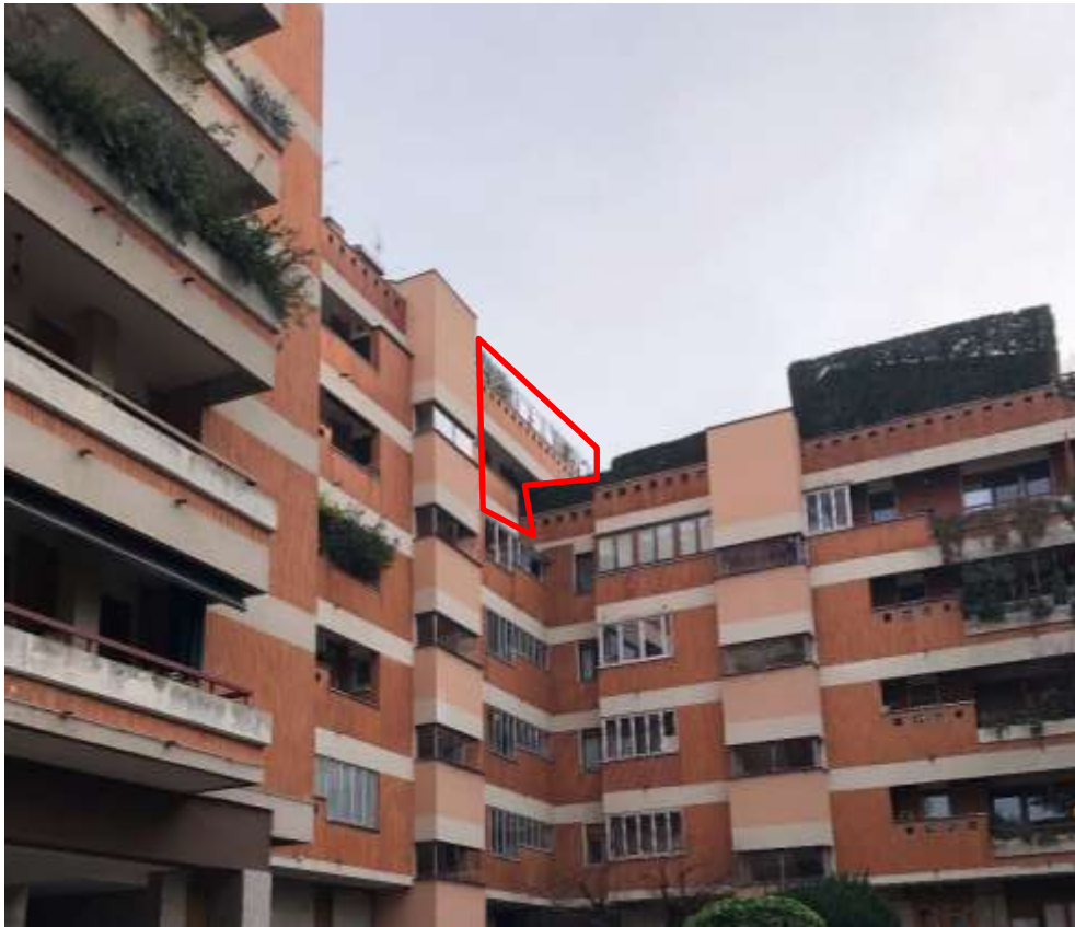
Viste fronte interno
