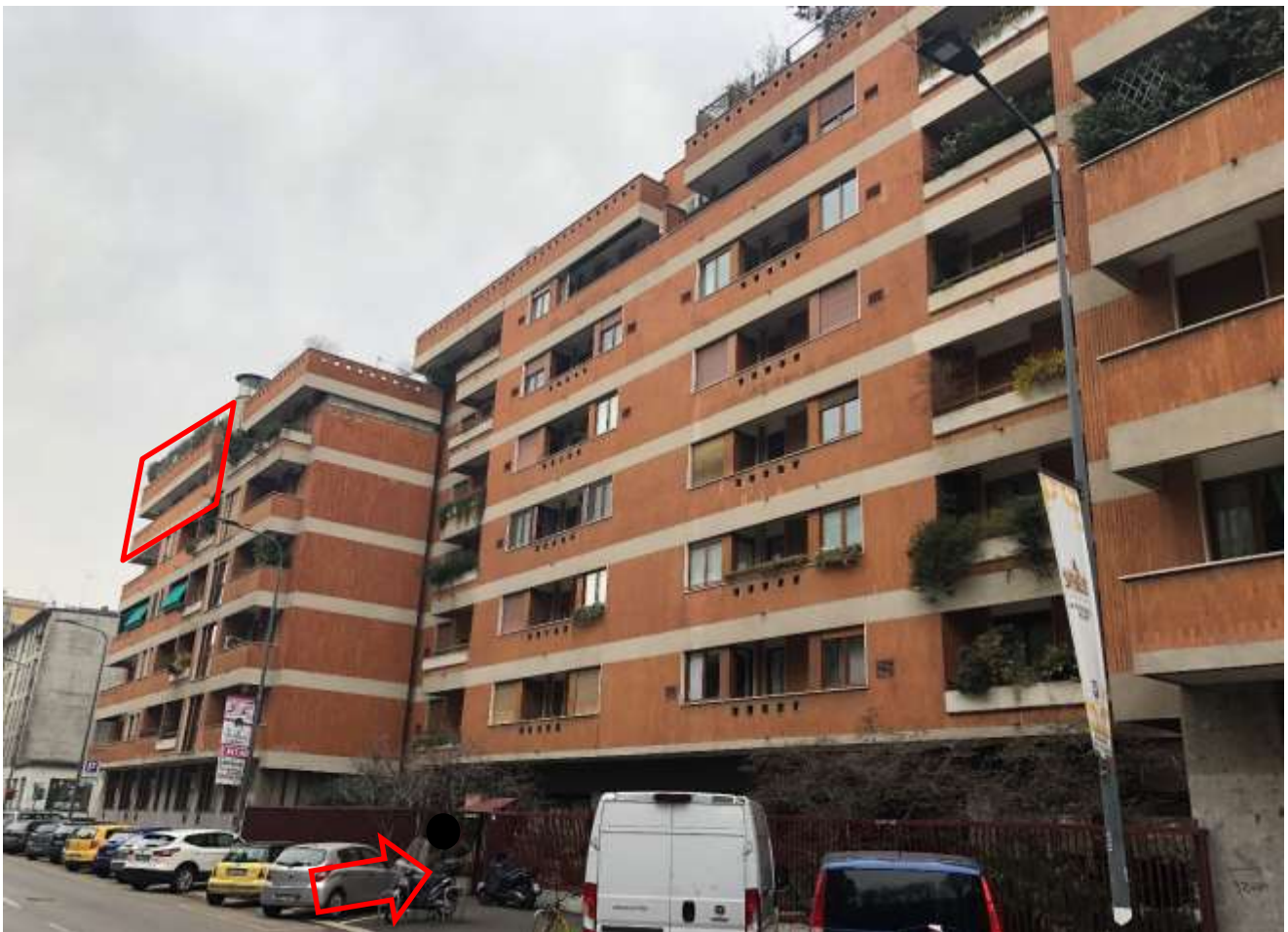
Vista edificio dal via Morosini
