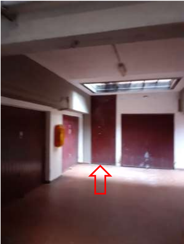
Vista porta di accesso a corridoio cantine
