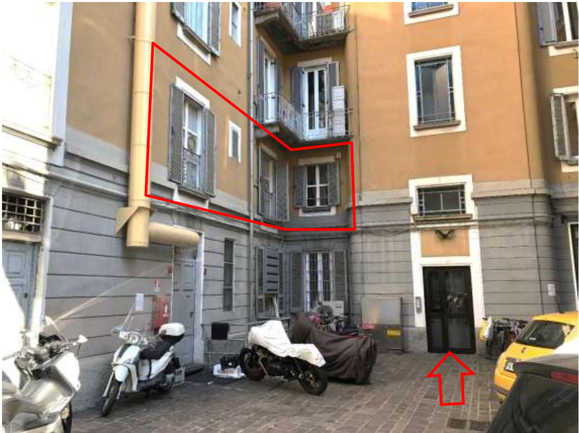
Vista cortile interno
